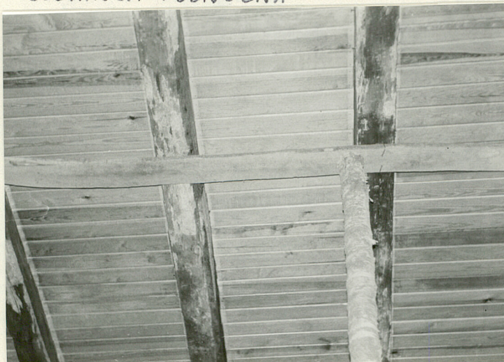
FRAGMENT STROPU BELKOWEGO (Z TYMCZASOWYM ZABEZPIECZENIEM)
