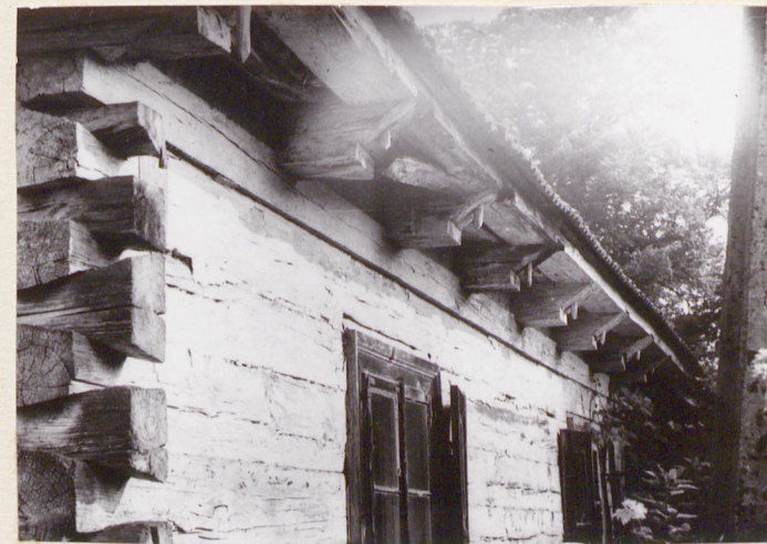
Elewacja boczna /zach/, krańce belek stropowych.
