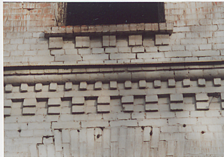
14. Gzyms pośredni i parapet podokienny
