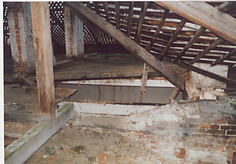
16. Widok więźby z zarwanym stropem piętra w części północnej
