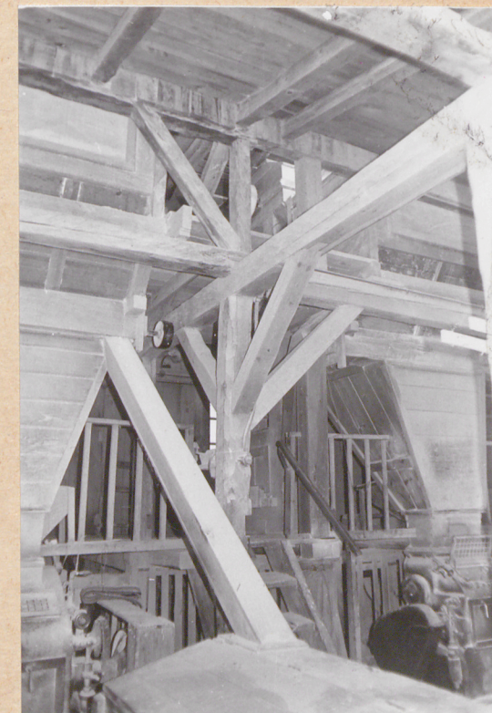
25. Wewnętrzna konstrukcja słupowa z mieczami.
