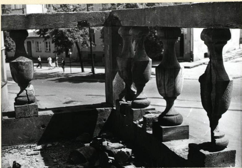
FOT.17 balustrada balkonu frontowego- tralki drewniane i cementowe
