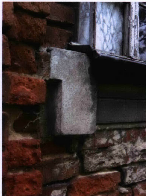
Destrukcja cegieł fasady
