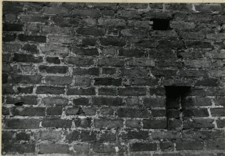
fot.10 watek muru. Widoczna zamurowana strzelnica i otwór maculcowy
