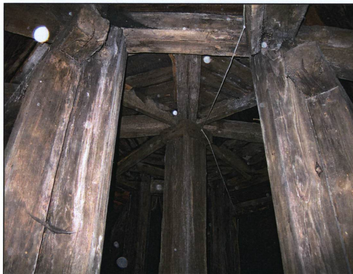
5. Konstrukcja nośna sygnaturki
