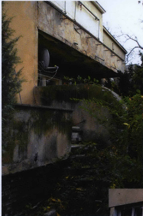
elevacja ogrodowa, opracowanie balustrady i licowanie tarasu, zachowany fragment pochwyty balustrady tarasu
