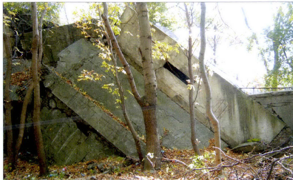
Elewacja na wysokości górnego zbiornika. Widoczny słup nr 7 i klatka schodowa z górną krawędzią zespoloną z murem. Konstrukcja zagłębiona częściowo w gruncie, pod kątem ok. 45°.
