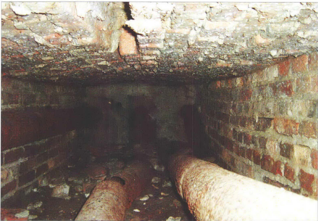
Podziemny kanał dla instalacji wodnej łączący najprawdopodobniej stację pomp (położoną po południowej stronie wieży ciśnieniowej) z wieżą, widok od strony podpiwniczenia.
