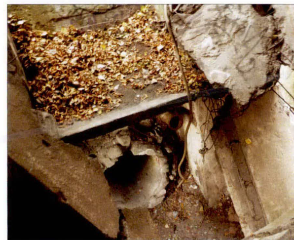
Strop nad V kondygnacją, pod dolnym zbiornikiem. Widoczny wylot centralnie położonej rury betonowej.
