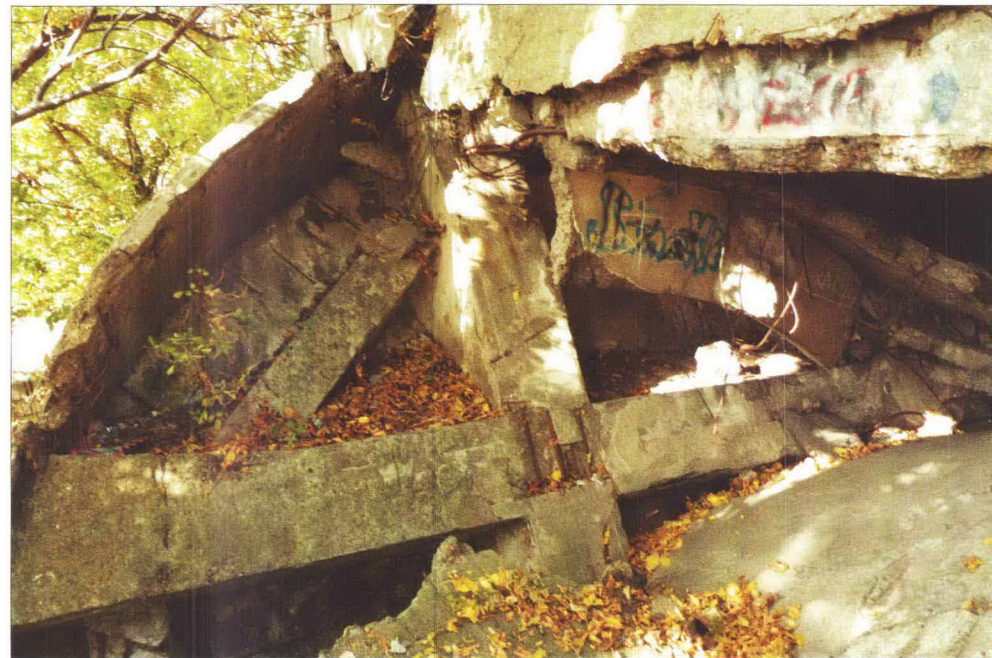
Konstrukcja wzmocnienia stropu, podciągi nad niższym zbiornikiem.
