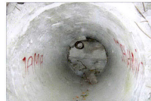
Wnętrze rury betonowej w obrębie dolnego zbiornika, w głębi pozostałości oryginalnej instalacji oraz strop nad zbiornikiem.
