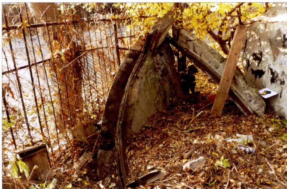
Fragment żelbetowej kopuły (od strony wewnętrznej) z górną częścią stalowej ramy okiennej.
