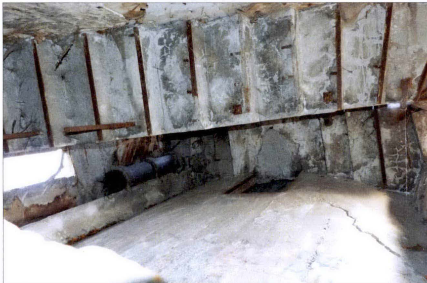
Zdjęcie wyżej i poniżej: Klatka schodowa i otwór prowadzący do korytarza rewizyjnego wokół górnego zbiornika. Widoczny odspojony od podłoża tynk wewnętrzny i izolacyjna płyta pilśniowa
