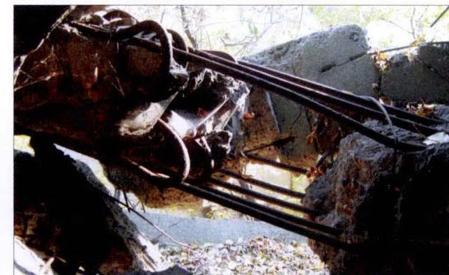
Zbrojenie słupa w wyższej części budynku.
