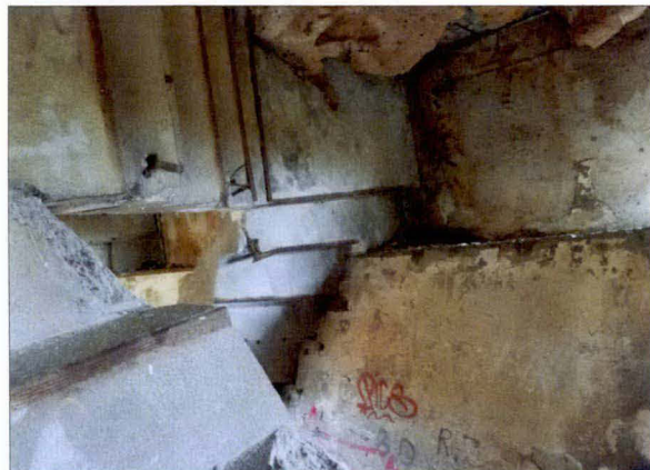
Niższa klatka schodowa, na stopniach wzmacniające i przeciwpoślizgowe stalowe progi, po prawej słup.
