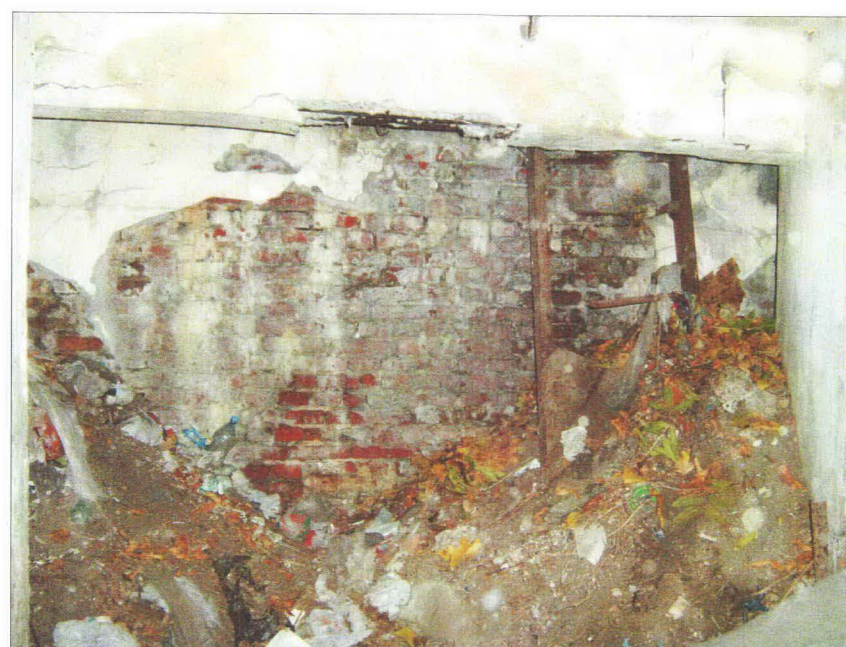
Zasypane gruzem i ziemią podpiwniczenie z pozostałościami stalowych schodów drabiniastych i słupem nr 1.
