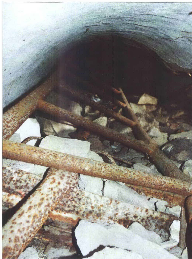
Stalowa drabina wewnątrz betonowej rury w obrębie górnego zbiornika.
