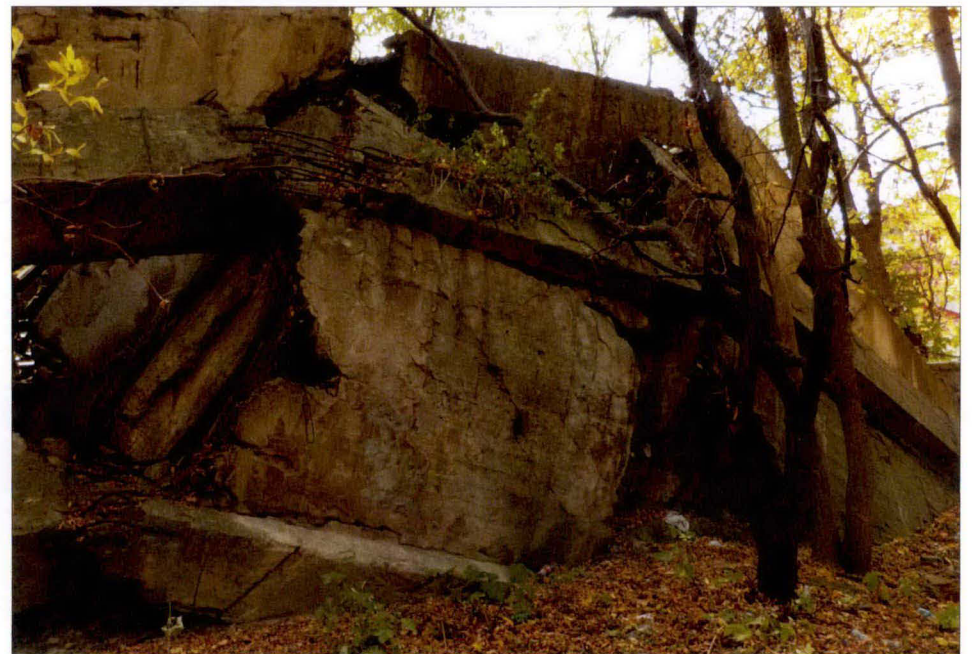
Górne kondygnacje ze zbiornikami. Widoczna strefa pęknięcia konstrukcji na wysokości spodu dolnego zbiornika.
