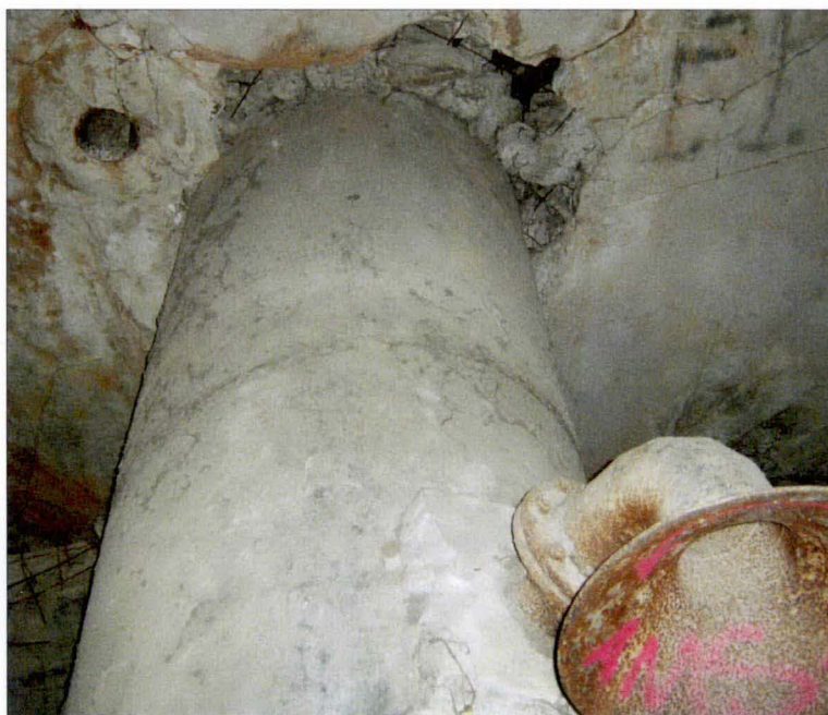
Wnętrze zbiornika dolnego, widoczna rura betonowa zamocowana centralnie w dnie zbiornika.
