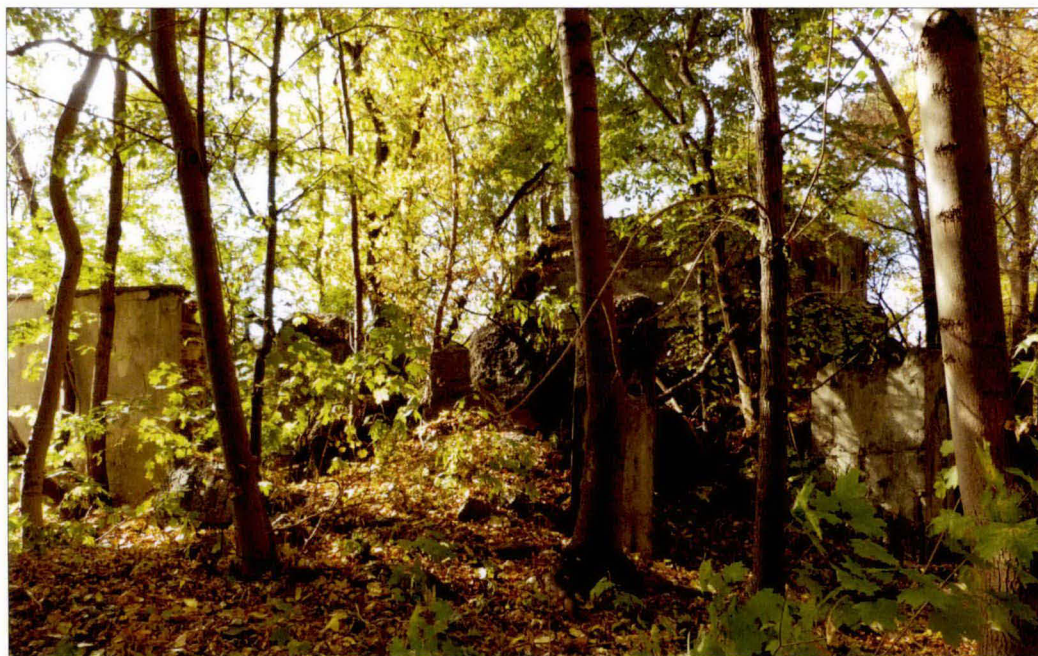
Pozostałości słupów nośnych, widok od strony wschodniej. Na pierwszym planie słup nr 8 (za pniem drzewa). Między nim a słupem za drzewem lekko pochyłym po lewej znajdowały się schody i wejście do budowli.
