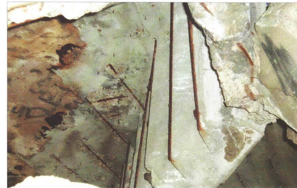
Wyższa część klatki schodowej, na ścianie widoczne pozostałości izolacji termicznej w postaci płyty piśniowej.
