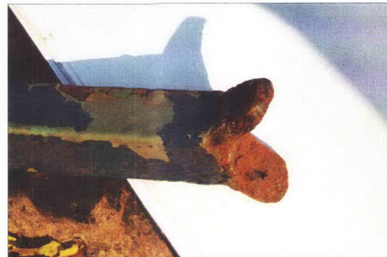
Pręt balustrady schodowej, miejsce mocowania pochwyty.
