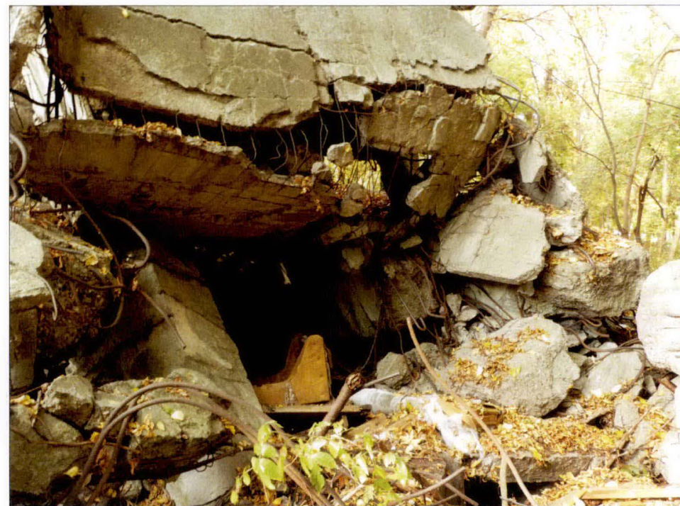
Silnie spękana i zdeformowana dolna część wschodniej elewacji (ściany klatki schodowej).
