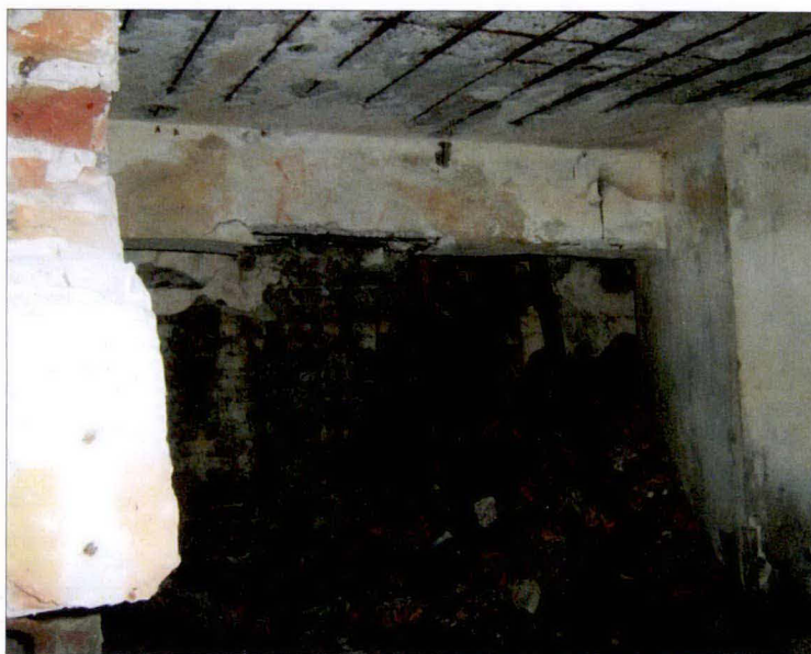
Pomieszczenie podpiwniczenia, widoczne stalowe schody drabiniaste na ścianie wschodniej. Po prawej słup nr 1 oryginalnie otynkowany.
