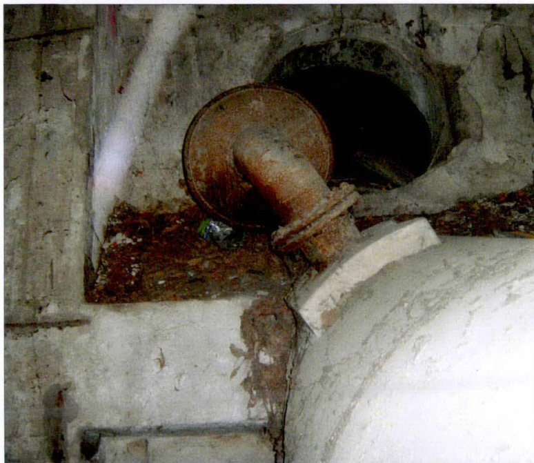
Wnętrze niższego zbiornika, widoczny centralny otwór w stropie i dyslokacja rury betonowej ze stalowym lejem przelewowym.
