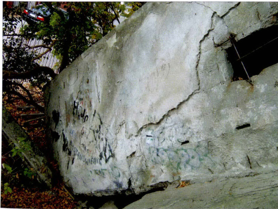
Szczytowy fragment klatki schodowej na wysokości górnego zbiornika. Widoczne fragmenty oryginalnego tynku.
