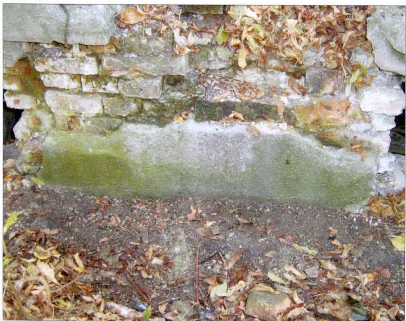
Górny fragment ściany fundamentowej podpiwniczenia i kondygnacji parteru.
