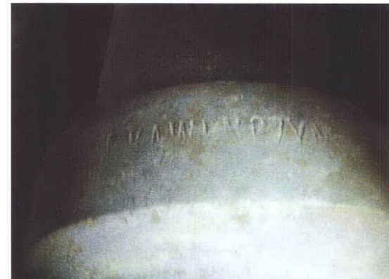
Ceramiczna rura spustowa instalacji odprowadzającej wodę deszczową z sygnaturą „KAWENCZYN”.
