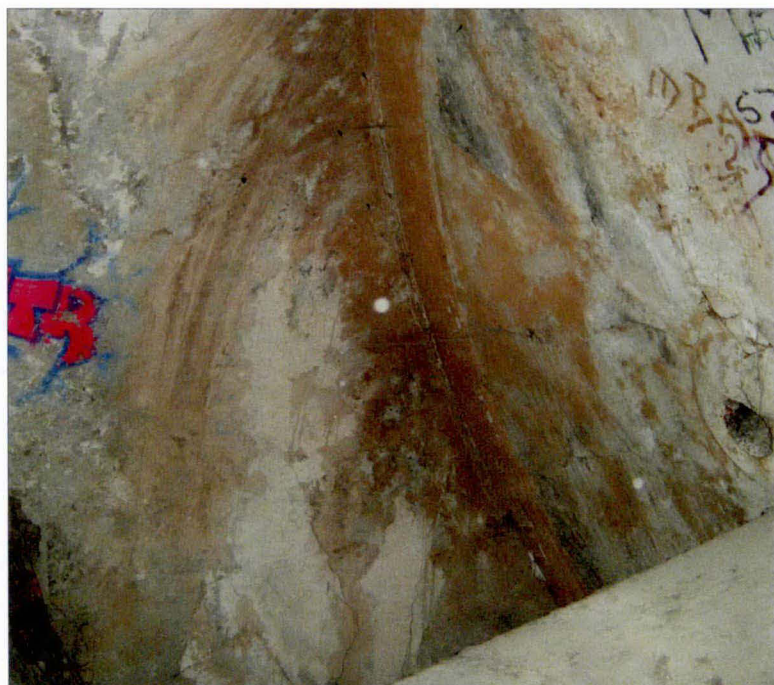
Wnętrze zbiornika dolnego, widoczny otwór w dnie zbiornika.
