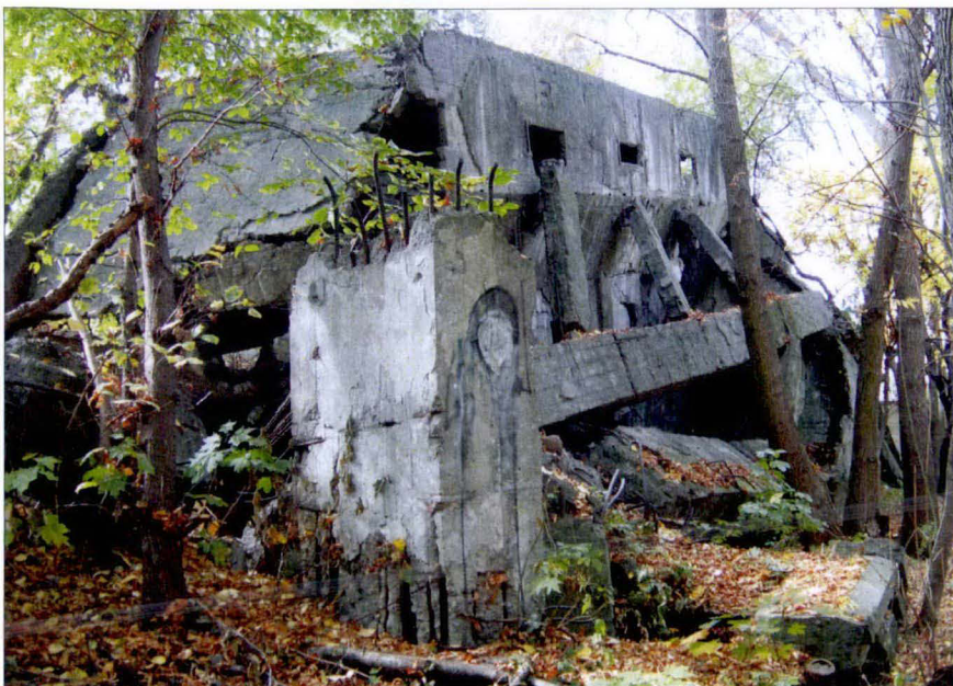
Pozostałości słupów nośnych, na pierwszym planie słup nr 7. W prawym dolnym rogu fragment zwieńczenia ściany fundamentowej podpiwniczenia i kondygnacji parteru. Widoczna klatka schodowa, słup nr 7 z łącznikami z klatką schodową i 6 (przy gruncie) Widok od strony północno-wschodniej.
