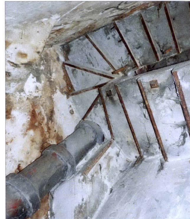
Klatka schodowa w wyższej części obiektu, widoczna ceramiczna instalacja odprowadzająca wodę deszczową z dachu przylegająca do słupa.
