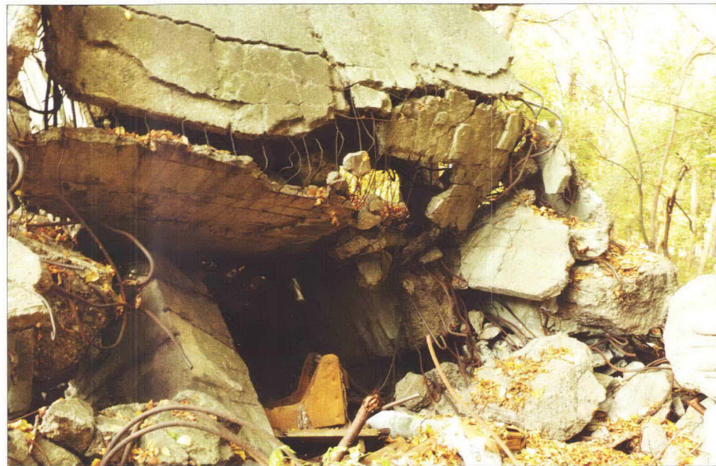
Elewacja wschodnia, na pierwszym planie zawinięta pod gruzowisko ściana klatki schodowej.
