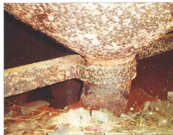
Elementy instalacji wodnej wewnątrz zbiornika stalowego w piwnicy.
