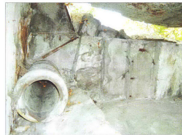
Wyższa klatka schodowa, pozostałości rury spustowej instalacji odprowadzającej wodę deszczową.
