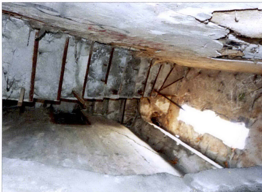
Zdjęcie wyżej i poniżej: Klatka schodowa i otwór prowadzący do korytarza rewizyjnego wokół górnego zbiornika. Widoczny odspojony od podłoża tynk wewnętrzny i izolacyjna płyta pilśniowa
