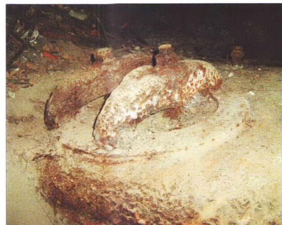
Pokrywa z zamknięciem stalowego zbiornika w piwnicy.
