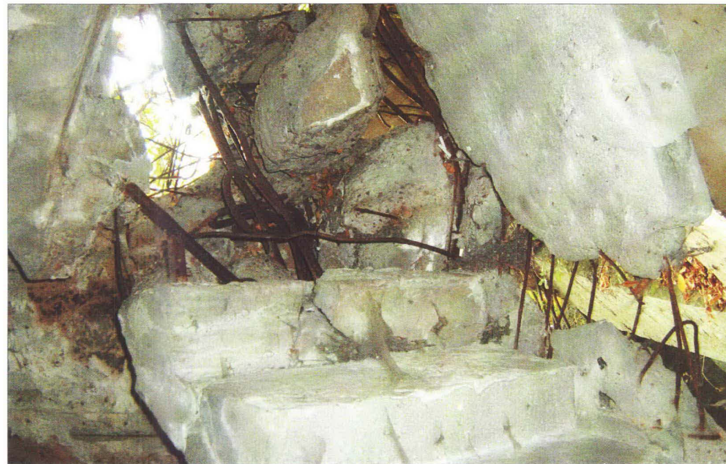
Zniszczone biegi klatki schodowej wyższej.
