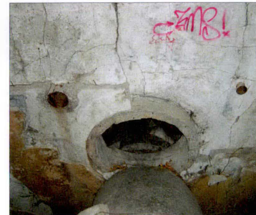
Dno zbiornika górnego, centralna rura betonowa odspojona od dna.
