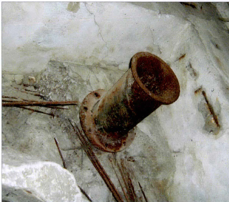
Strop pod dolnym zbiornikiem. Widoczna stalowa rura spustowa oraz fragment rury betonowej.
