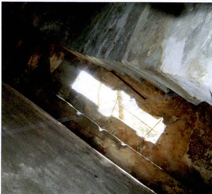
Fragment klatki schodowej na wysokości górnego zbiornika pomiędzy ścianą zewnętrzną a ścianą zbiornika. Widoczny oryginalny pręt balustrady i fragmenty tynku wewnętrznego.
