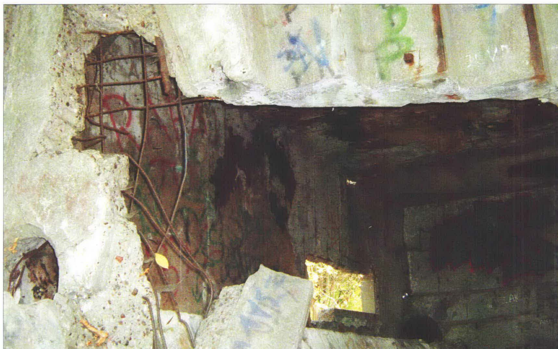
Klatka schodowa, u dołu poziomo widoczny słup nośny oraz otwory w stropach dla instalacji odprowadzającej wodę deszczową poprowadzonej wzdłuż słupa.
