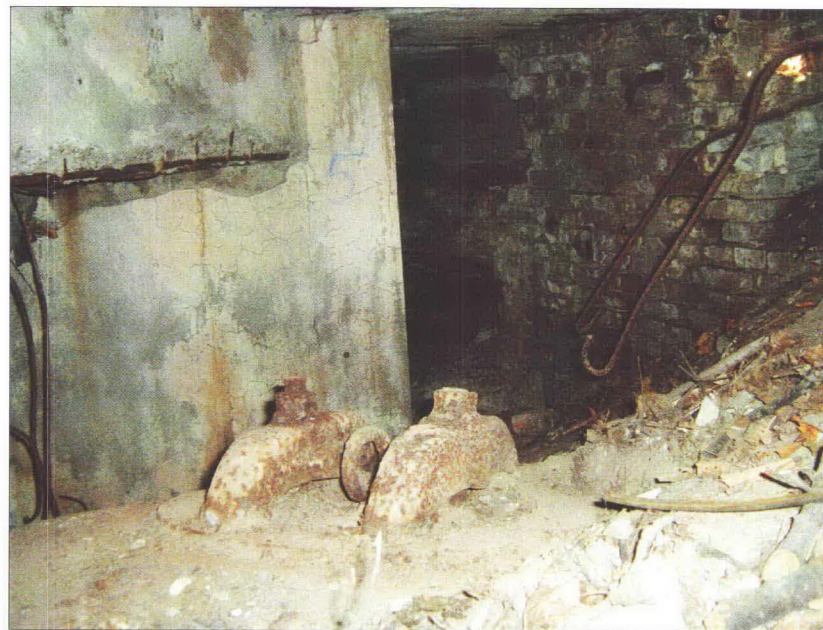
Zagruzowane wewnątrz podpiwniczenia, widoczny słup nr 4 oraz górna część stalowego spawanego zbiornika.
