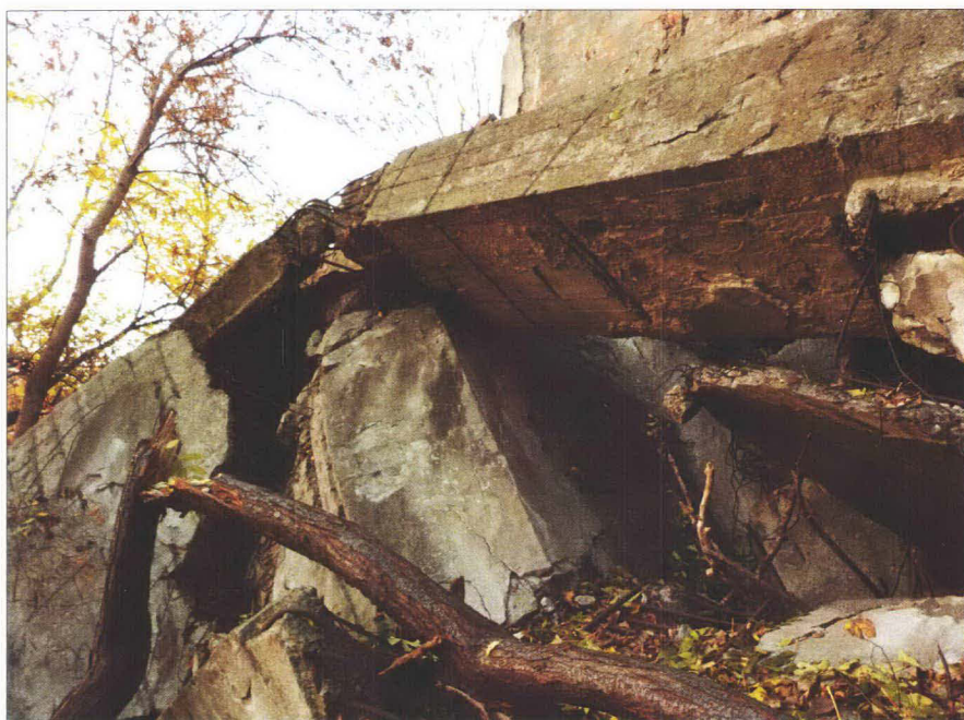
Przełamanie konstrukcji na wysokości spodu dolnego zbiornika, widok od strony południowo-wschodniej.
