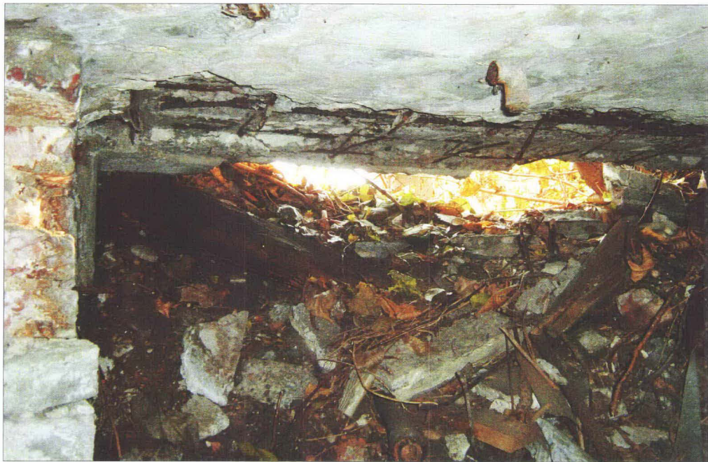
Strop podpiwniczenia – po lewej fragment ceglanej ściany fundamentowej.
