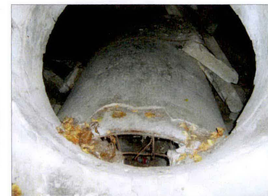
Otwór w stropie pomiędzy zbiornikami, widoczna rura betonowa oderwana od dna górnego zbiornika.
