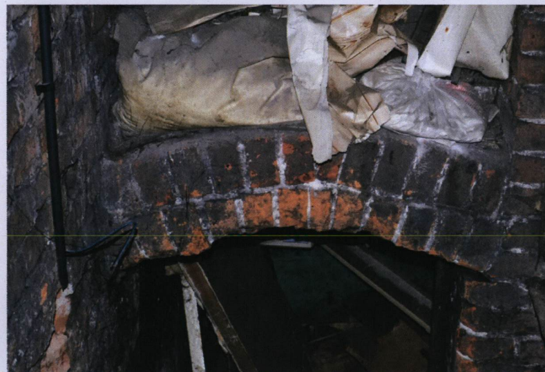
3. Podest klatki schodowej 4. Sklepienie odcinkowe fragmentu podpiwniczenia pod klatką schodową
