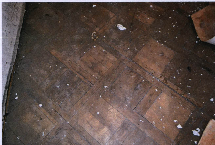
Zachowany parkiet taflowy w jednym z pokoiów na piętrze
