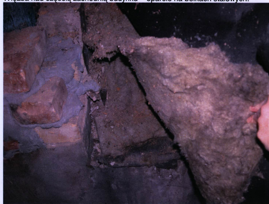
Docieplenie łupiny nad kaplicą z wełny mineralnej nakryte papą.
