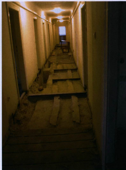
Odkryte stropy w trakcie korytarza piętra – po lewej widoczna granica zabudowy barokowej ze sklepieniami.
