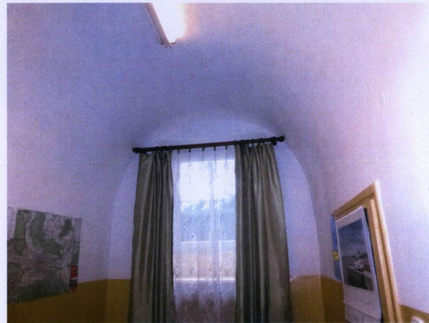
Sklepienie kolebkowe w pomieszczeniu przy schodach na poziomie niskiego parteru.
