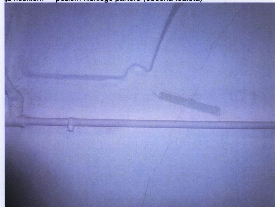
Detal opracowania oporu sklepień na ścianach. Widoczna plomba szklana na spękaniu ściany.
