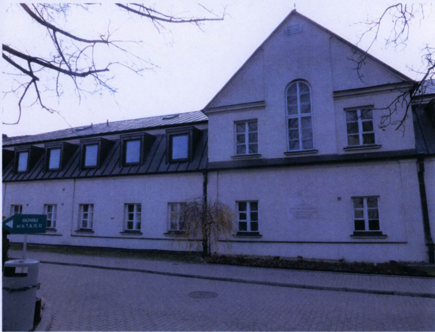
Zachowane okna skrzynkowe w parterze i kaplicy na piętrze.
