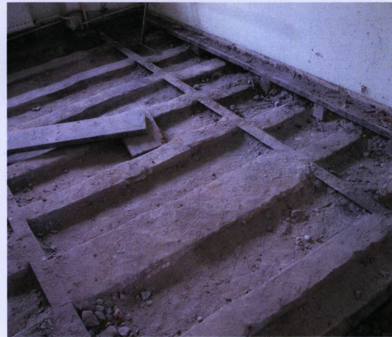
Odkryty strop Kleina nad traktem w pomieszczeniu d. konwiktu. Podłogi drewniane na legarach i skrzydła drzwiowe zdemontowane.
