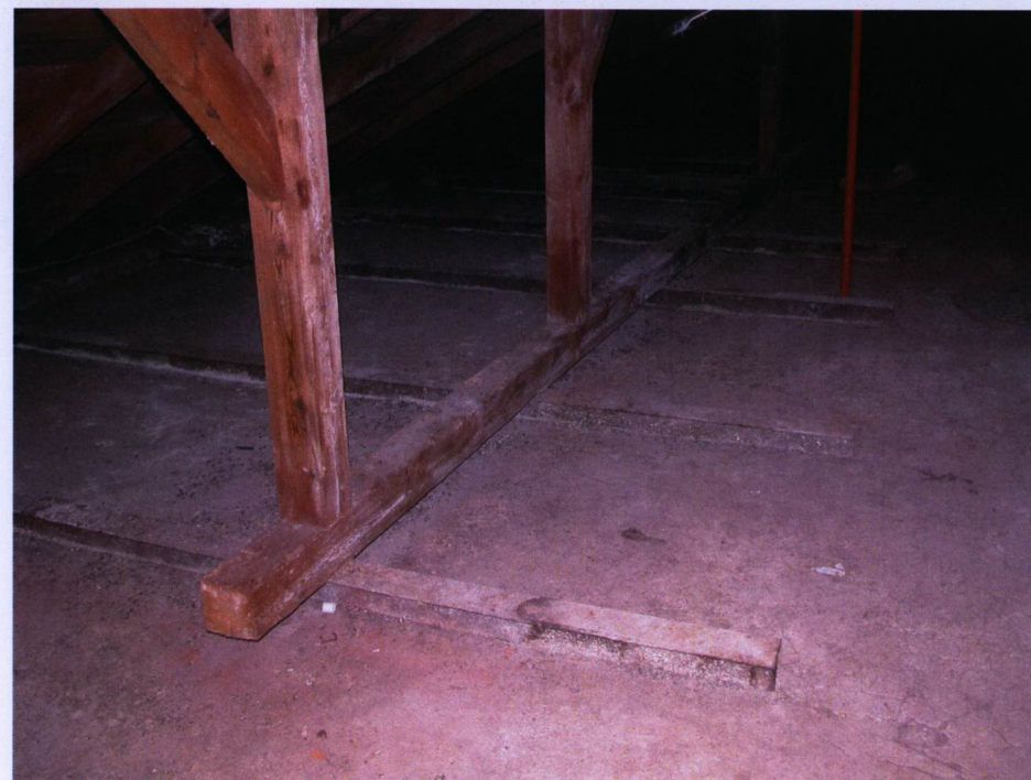
Więźba nad częścią zachodnią budynku – oparcie na belkach stalowych.
