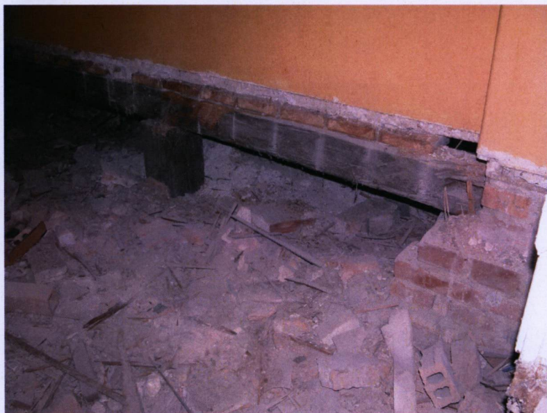
Konstrukcja ścianki ceglanej (dziurawka) wsparta na belce drewnianej nad sklepieniem od. oficyny.
