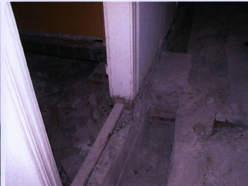
Sklepiony trakt d. oficyny nie pokrywa się z podziałem na trakty piętra d. Domu Zgromadzenia Księży Marianów, po lewej odkryte sklepienia oficyny i po prawej strop Kleina oparty na jej ścianie.
