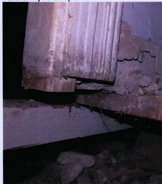
Konstrukcja ścianki ceglanej posadowionej na podłodze z desek na legarach, a nie bezpośrednio na stropie.
