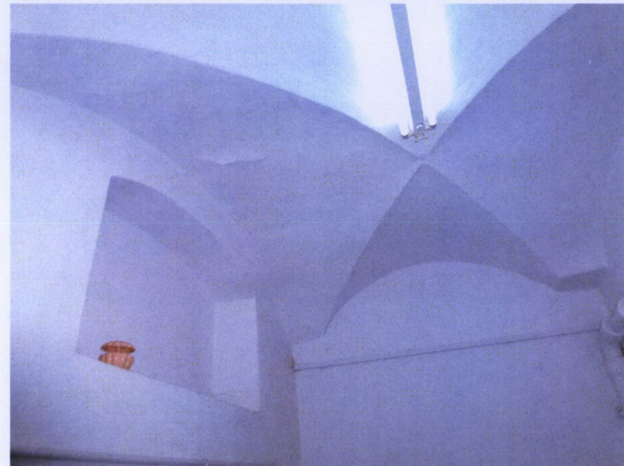
Sklepienie krzyżowe – szwy opracowane w tynku tak jak w eremach „z noskiem” – poziom niskiego parteru (obecna toaleta)
