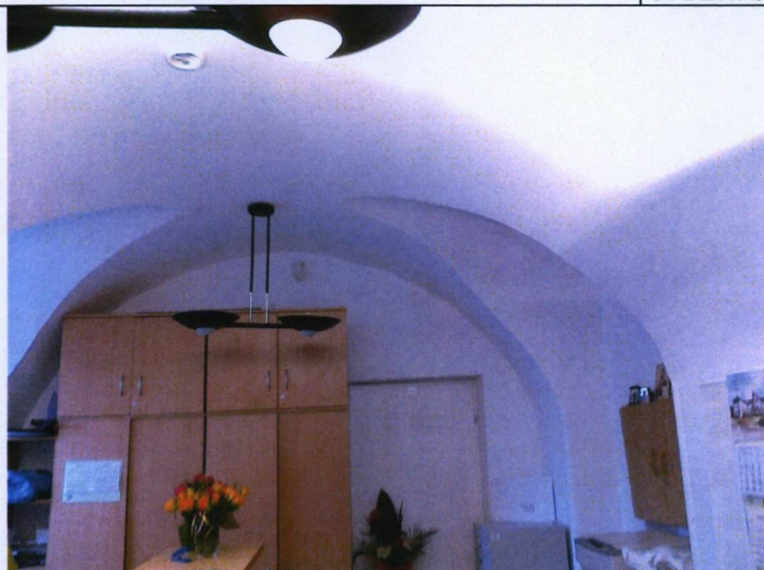
Sklepienie kolebkowe z lunetami – w poziomie wysokiego parteru, oficyna gosp.
