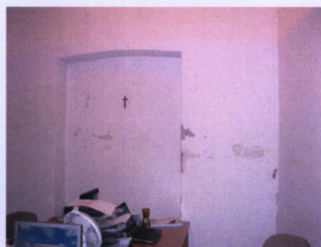
Ślady zawilgoceń w ścianie zachodniej skrzydła wschodniego.
