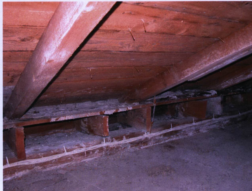
Oparcie krokwi na ścianach zewnętrznych – konstrukcja pośrednia nad namurnicami.
