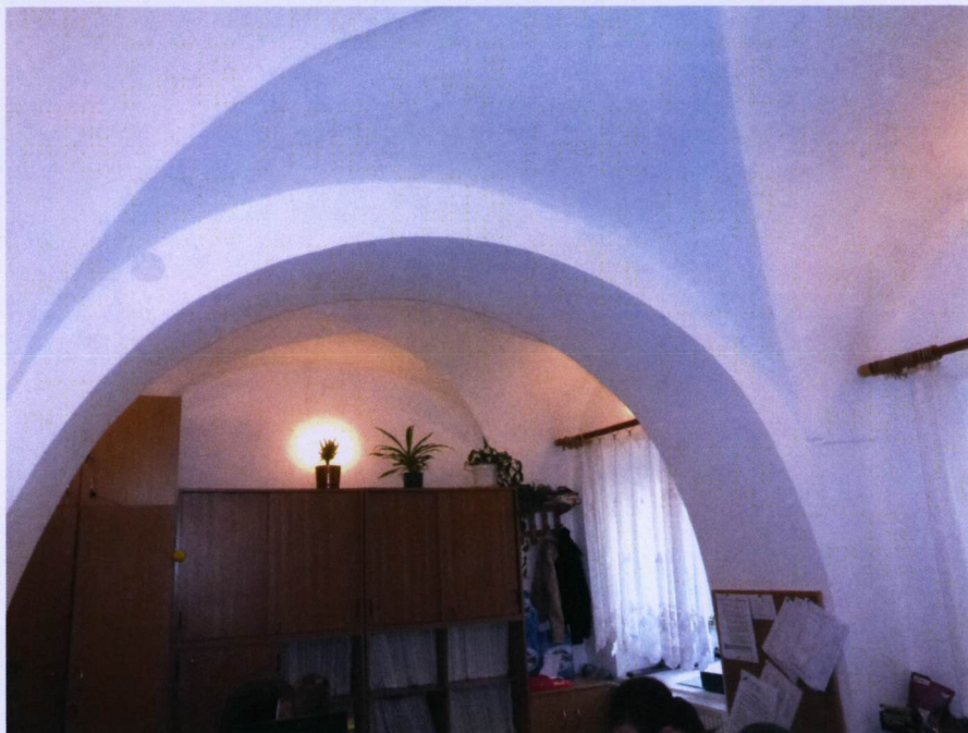
Sklepienia krzyżowe z gurtami dzielącymi przęsła w oficynie gospodarczej – poziom niskiego parteru.
