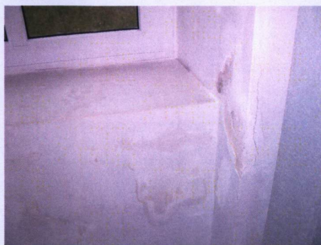
Ślady zawilgoceń w ścianie zachodniej skrzydła wschodniego.
