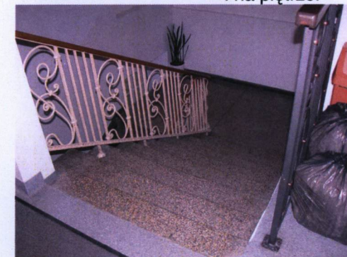
Główne schody z lastrico – na parterze i na piętrze.
