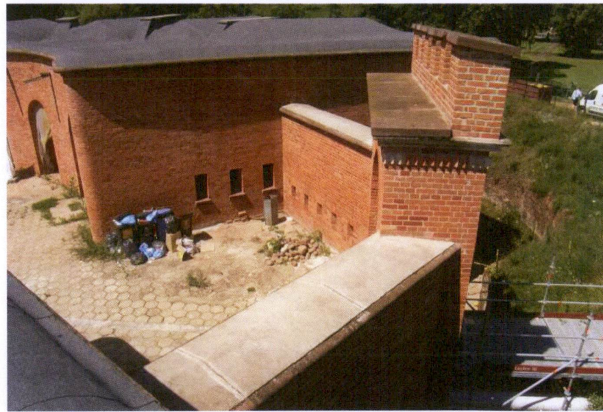
Ryc. 39z Mur szczytowy wieży artyleryjskiej z bramą po konserwacji cegły i wykonaniu nowej nadlewki z betonu. Zdjęcie: S. Fuglewicz, lipiec 2020 r.
