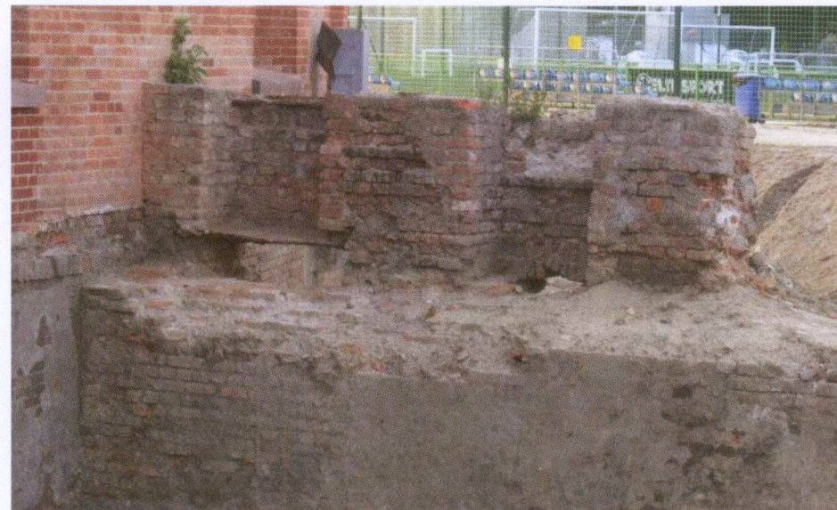
Ryc. 58f. Odcinek muru szyjowego lunety przy wschodniej elewacji wieży artyleryjskiej z zachowanym fragmentem przedpiersia. Widoczne otwory machikuł, prawy z zachowanym łukiem. Zdjęcie: S. Fuglewicz, czerwiec 2018 r.
