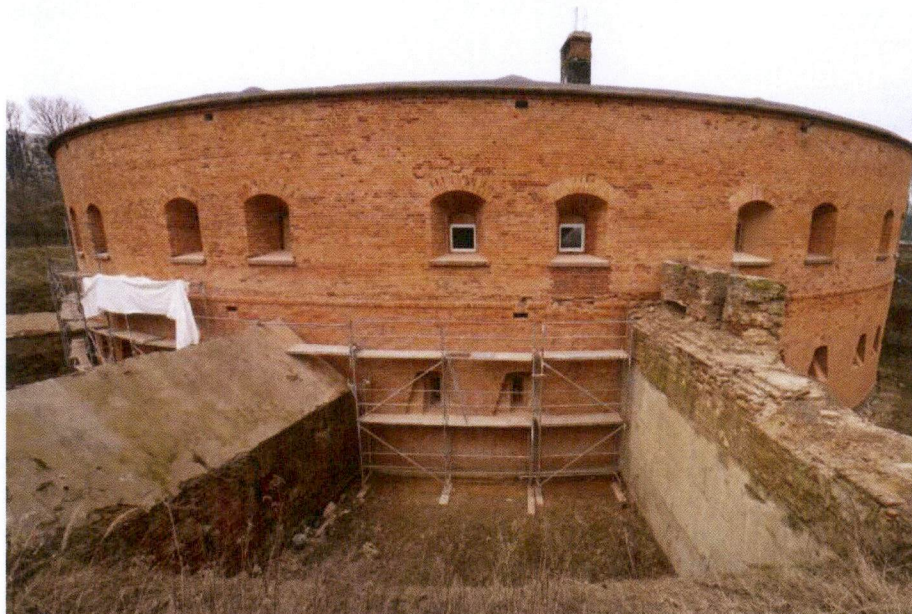
Ryc. 39i Elewacja wieży artyleryjskiej w trakcie prac konserwatorskich. Z lewej strony kaponiera, z prawej mur szyjowy lunety z zachowanym fragmentem przedpiersia. Zdjęcie: Asman Pieniężny Architekci sp z o. o., marzec 2021 r.
