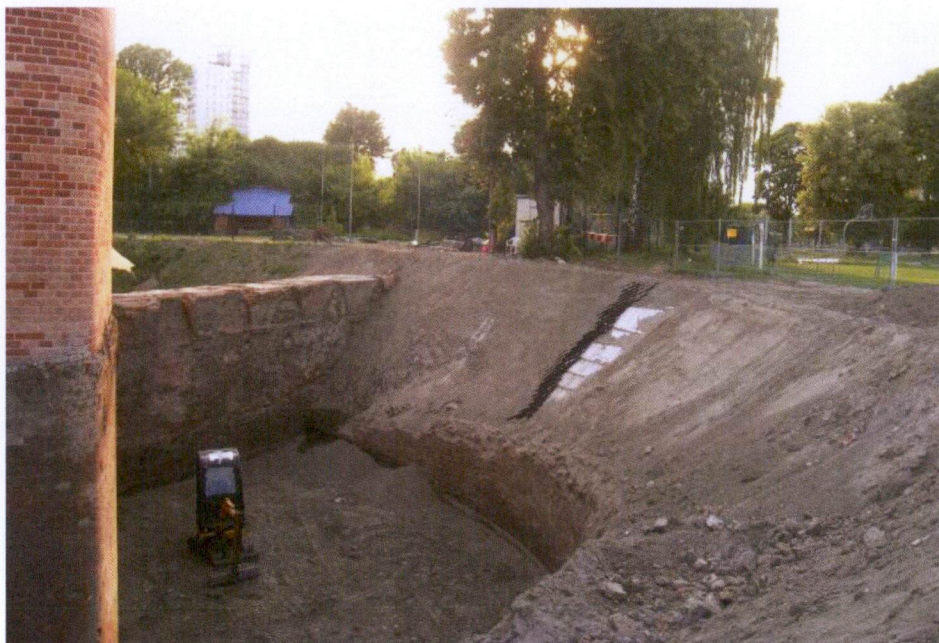
Ryc. 58a Fosa wieży artyleryjskiej w trakcie odkopywania. Widoczny odcinek muru szczytowego lunety z kroksztynami i przeciwskarpą obniżoną zgodnie z profilem fosy szczytowej lunety. Zdjęcie: S. Fuglewicz, czerwiec 2018 r.
