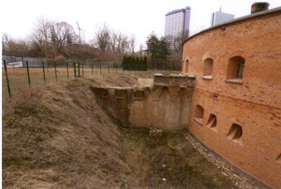
Ryc. 39j Elewacja wieży artyleryjskiej z fragmentem fosi. Widoczny odcinek muru szyjowego lunety z przedpiersiem wspartym na kroksztynach i strzelnica karabinowa przekształcona na artyleryjską. Zdjęcie: Asman Pieniężny Architekci sp z o. o., marzec 2021 r.
