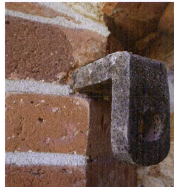
Ryc. 39u Wzrostek kraty uchylnej w policzku z ryciny 39t. Widoczny gwint w otworze. Zdjęcie: Asman Pieniężny Architekci sp z o. o., sierpień 2021 r.
