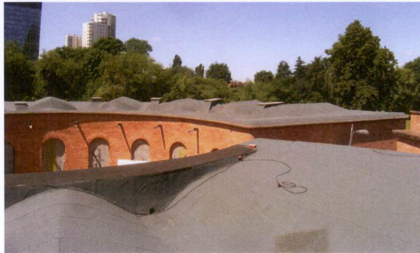
Ryc. 39x Strop wieży artyleryjskiej po pokryciu papą. Zdjęcie: S. Fuglewicz, lipiec 2020 r.
