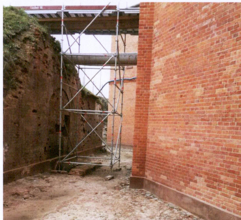
Ryc. 58g. Fosa wieży artyleryjskiej - przeciwskarpa z przyczółkiem mostowym. Widoczna płycina imitująca wejście, brukowane dno fosy, obmurowanie studzienki i oparcie podpór mostu. Zdjęcie: Asman Pieniężny Architekci sp z o. o., styczeń 2020 r.
