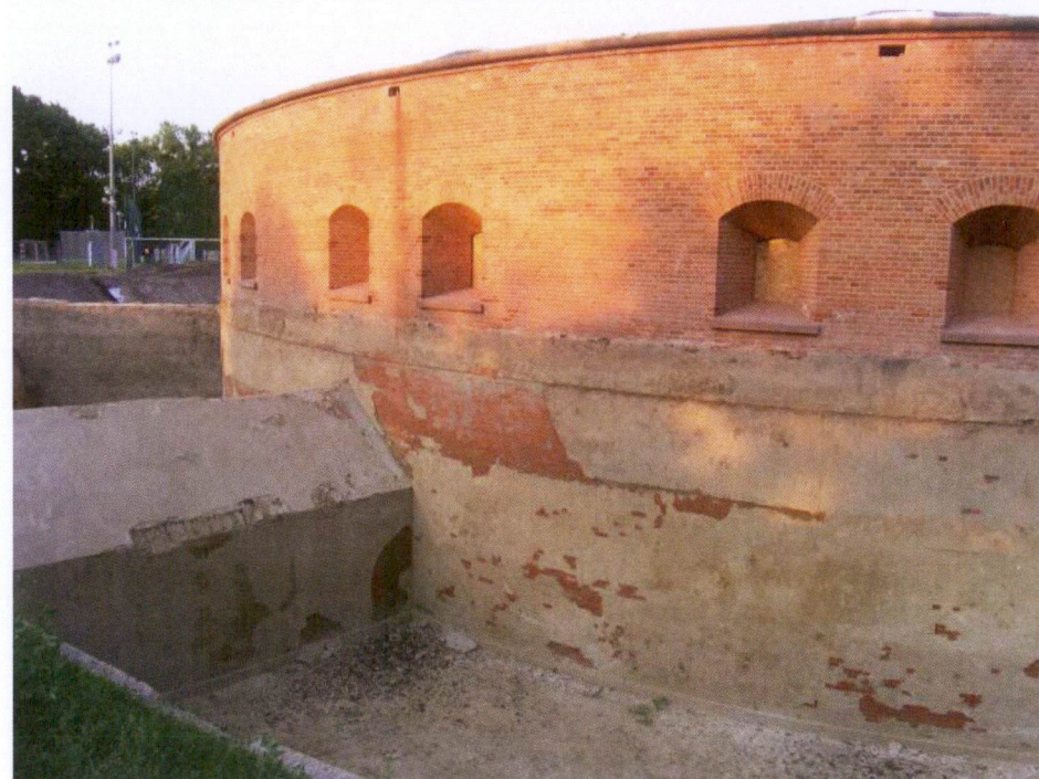
Ryc. 58b Fosa wieży artyleryjskiej po odkopaniu i przed pracami konserwatorskimi. Elewacja wieży i widoczna z lewej kaponiera pokryte zaprawą. Zdjęcie: S. Fuglewicz, czerwiec 2018 r.
