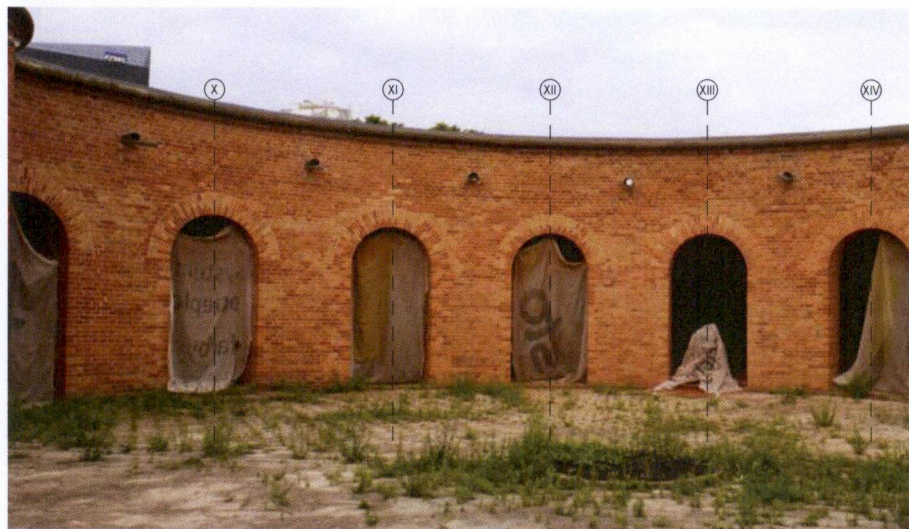
Ryc. 39n, 39o Elewacja wewnętrzna wieży artyleryjskiej po pracach konserwatorskich wykonanych przed 2020 rokiem - część zachodnia i północno-wschodnia. Osie oznaczone według rysunku rzutu 39a. Dziedziniec pokryty trylinką ułożoną na bruku i zasłaniającą część cokołu. Pośrodku nadmurowana cembrowina odkopanej studni, zabezpieczona kratą. Zdjęcie: Asman Pieniężny Architekci sp z o. o., lipiec 2021 r.
