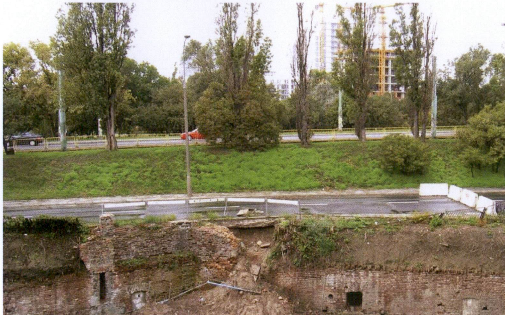
Ryc. 7a Wyrwa w jezdni ul. Bonifraterskiej nad uszkodzonym fragmentem galerii przeciwskarpowej fosi (rowu fortecznego) lunety w narożu prawego czoła i barku, stan przed prowizoryczną naprawą. Widok ze wschodu (z wału). Fot. S. Fuglewicz, 5.09.2006 r.
