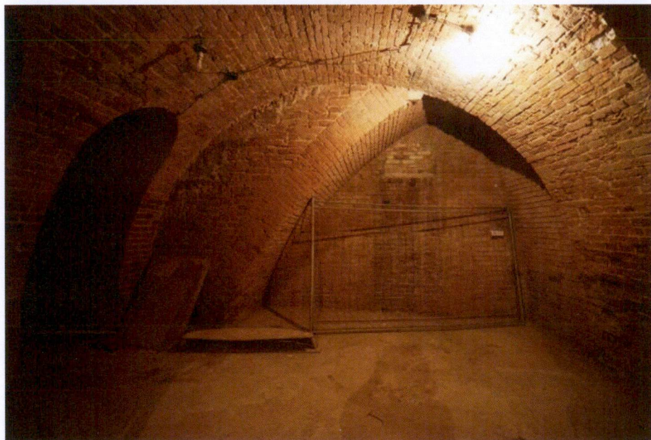
Ryc. 39ii, Dolna kondygnacja sala na osi XV, widok w kierunku ściany szczytowej. Widoczny łuk podpierający schody i kamienne stopnie, pod łukiem zamurowany otwór doświetlający. Zdjęcie: Asman Pieniężny Architekci sp z o. o., lipiec 2021 r.
