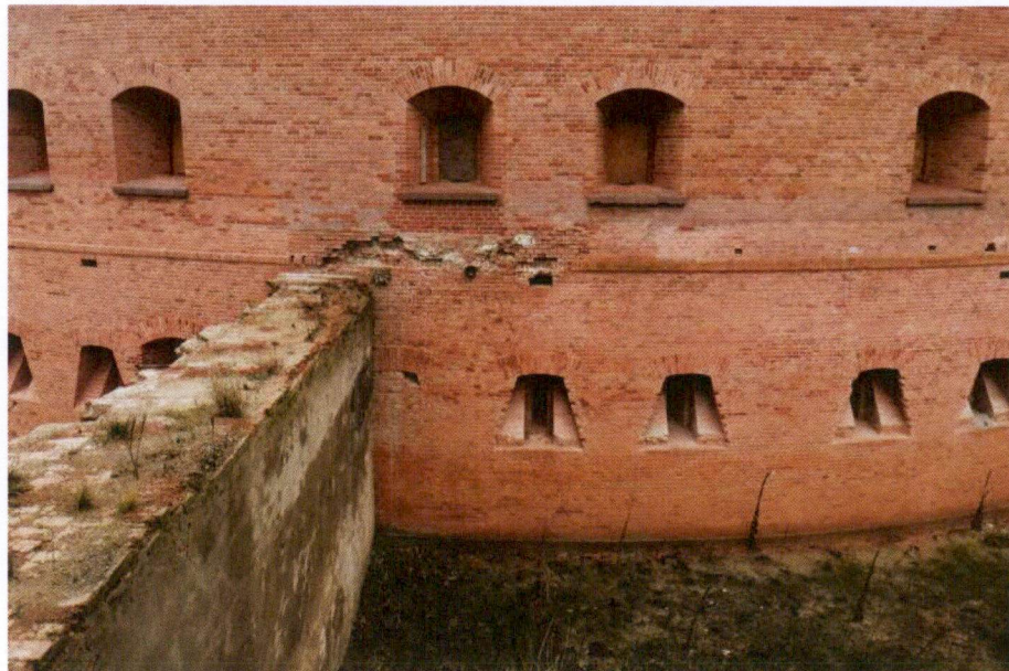
Ryc. 39h Elewacja wieży artyleryjskiej w trakcie prac konserwatorskich i fragment fosi. Z lewej strony odcinek muru szyjowego lunety z resztkami żelaznych kotew w koronie, przy niej zamurowana strzelnica. Zdjęcie: Asman Pieniężny Architekci sp z o. o., styczeń 2020 r.
