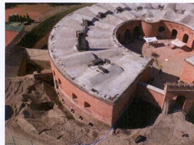
Ryc. 7e Wieża artyleryjska w trakcie odkopywania rowu fortecznego (fosi) w ramach prac konserwatorskich. Widok z północnego wschodu. Widoczny odsłonięty strop i dziedziniec wewnętrzny wieży z jej wewnętrzną elewacją po przeprowadzeniu prac konserwatorskich., maj 2018r.
