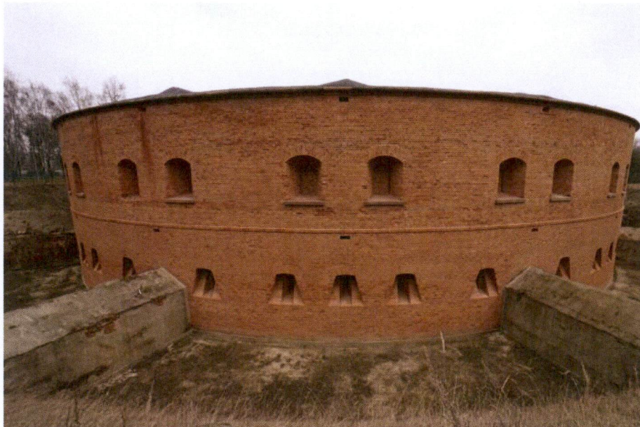
Ryc. 39g Elewacja zewnętrzna wieży artyleryjskiej. W górnej kondygnacji strzelnice artyleryjskie, w dolnej karabinowe; widoczne wykonanie w poprzek fosi trzy łączniki i z lewej strony w głębi kaponiera grodzowa. Zdjęcie: Asman Pieniężny Architekci sp z o. o., marzec 2021 r.
