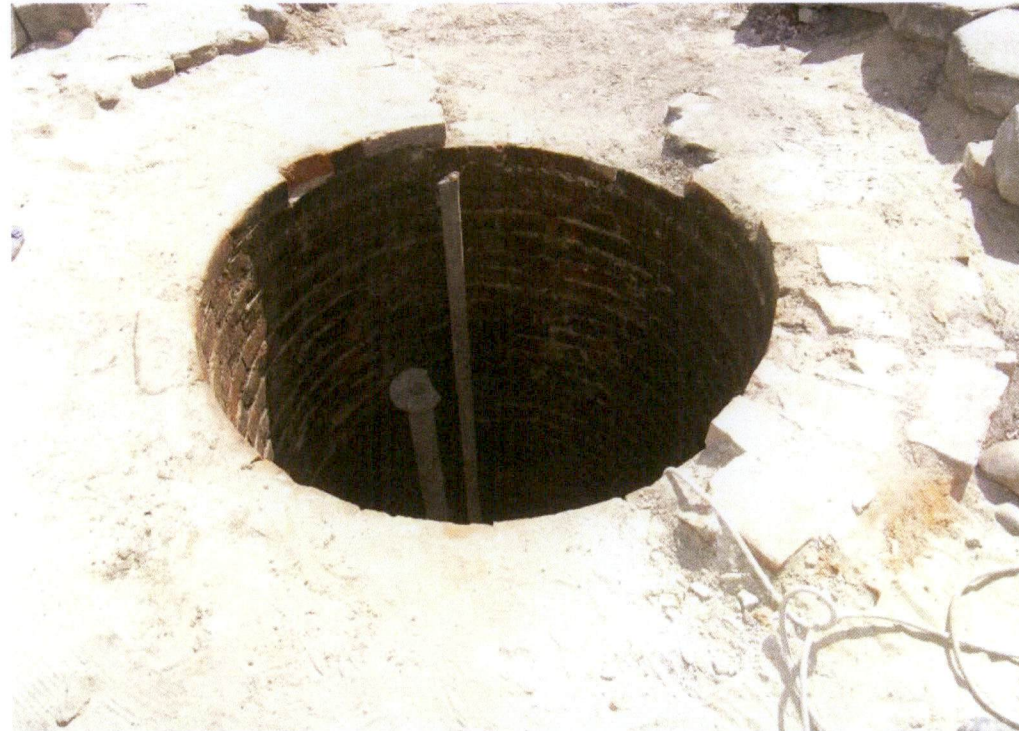
Ryc. 11b. Cembrowina studni na dziedzińcu wieży artyleryjskiej w trakcie jej odkopywania. U góry z lewej fragment oryginalnego bruku. Zdjęcie: S. Fuglewicz; sierpień 2014 r.
