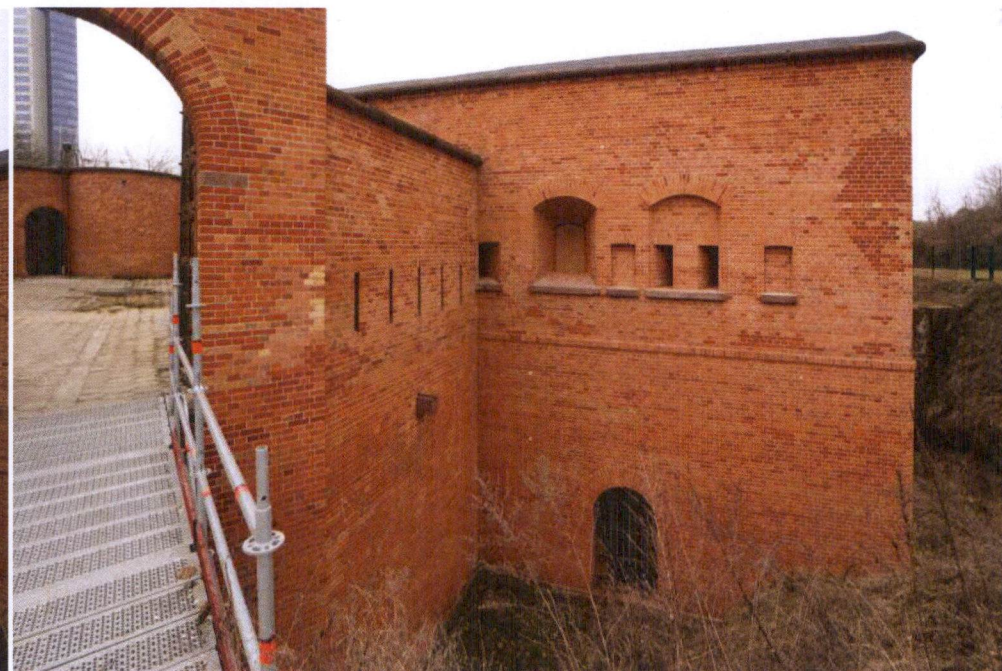
Ryc. 39f Elewacja wieży artyleryjskiej Fortu Traugutta w Warszawie. Otwory strzelnicze częściowo zamurowane i częściowo otwarte oraz wyjście do rowu fortecznego. Zdjęcie: Asman Pieniężny Architekci sp z o. o., marzec 2021 r.
