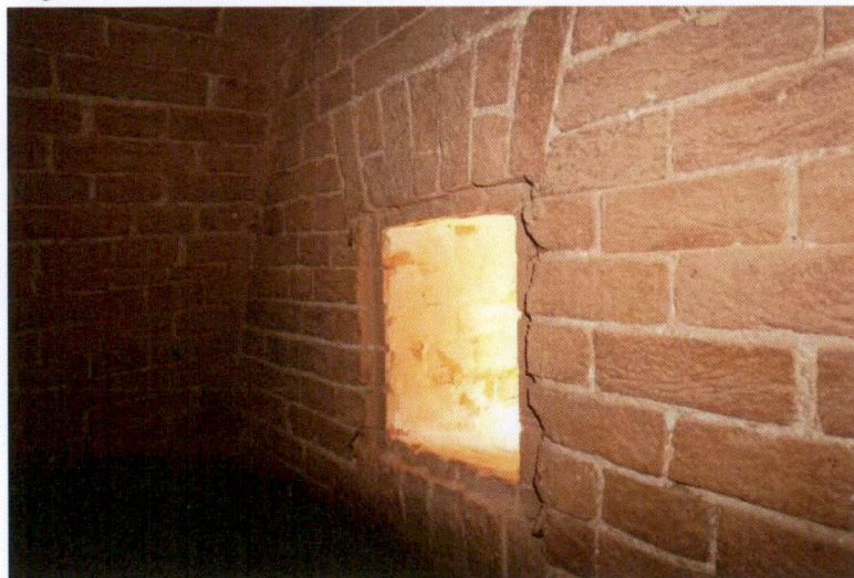
Ryc. 11c. Wlot strzelnicy karabinowej w dolnej kondygnacji wieży artyleryjskiej po usunięciu zamurowania. Widoczne resztki kotew do mocowania ościeżnicy. Zdjęcie: Asmah Pieniężny Architekci sp z o. o.; sierpień 2021 r.
