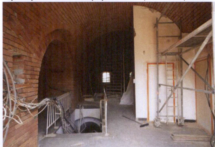
Ryc. 39ee Sala na kond. 0 (oś I). Widoczne współczesne ścianki działowe z lewej wnętrza ze strzelnicami karabinowymi, w głębi strzelnice artyleryjskie. Zdj. Asman Pieniężny Architekci sp z o. o., sierpień 2021 r.
