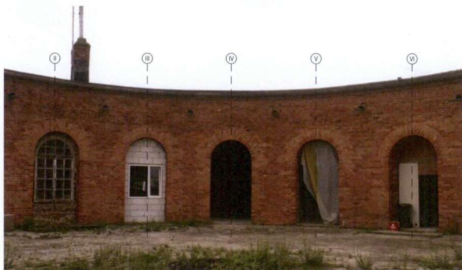
Ryc. 39p, Elewacja wewnętrzna wieży artyleryjskiej po pracach konserwatorskich wykonanych przed 2020 r. Część południowo-wschodnia. Widoczne zachowane okno - po przekształceniach z wcześniejszego okresu. Nad gzymsem jeden zachowany komin. Zdjęcie: Asman Pieniężny Architekci sp z o. o., lipiec 2021 r.
