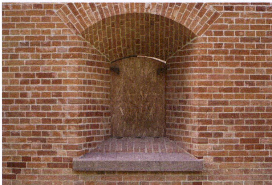
Ryc. 39t Strzelnica artyleryjska w górnej kondygnacji z zachowanymi elementami mocowania kraty uchylnej - w policzkach dwa wsporniki, w parapecie dwa gniazda i otwór na trzpień ławety. Kamienny parapet odtworzony podczas prac konserwatorskich. Zdjęcie: Asman Pieniężny Architekci sp z o. o., sierpień 2021 r.
