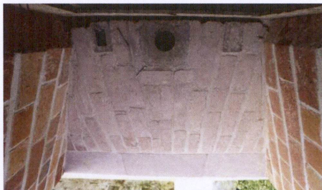
Ryc. 39t Strzelnica artyleryjska w górnej kondygnacji z zachowanymi elementami mocowania kraty uchylnej - w policzkach dwa wsporniki, w parapecie dwa gniazda i otwór na trzpień ławety. Kamienny parapet odtworzony podczas prac konserwatorskich. Zdjęcie: Asman Pieniężny Architekci sp z o. o., sierpień 2021 r.
