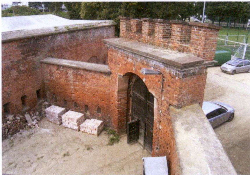
Ryc. 39y Mur szczytowy wieży artyleryjskiej z bramą przed pracami konserwatorskimi. Zwieńczenie bramy - płyta i krenelaż nad gzymsem - z okresu powojennego. Zdjęcie: S. Fuglewicz, sierpień 2014 r.
