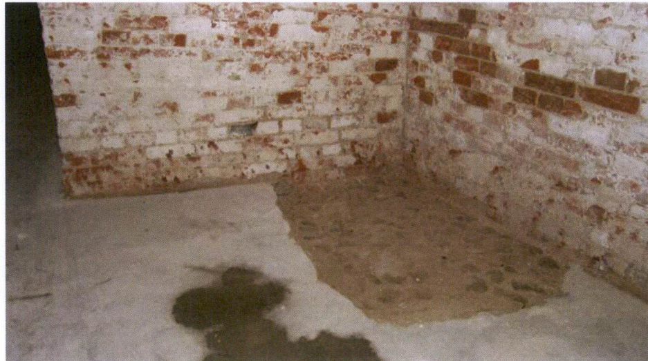
Ryc. 11d. Dolna kondygnacja wieży artyleryjskiej - fragment oryginalnego bruku odslonięty spod betonowej wylewki w trakcie badań. Po prawej ściana czołowa ze strzelnicami. Zdjęcie: S. Fuglewicz; sierpień 2014 r.
