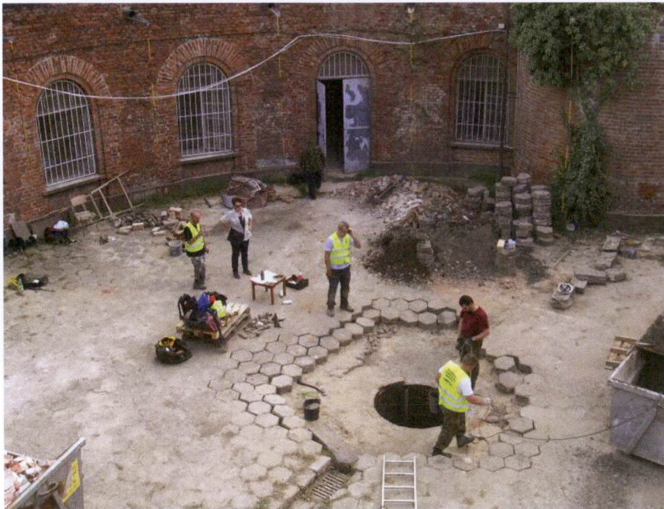
Ryc. 11a. Dziedziniec wieży artyleryjskiej podczas eksploracji studni, widoczna ceglana cembrowina i częściowo zachowany pod trylinką oryginalny bruk. Zdjęcie: S. Fuglewicz; sierpień 2014 r.
