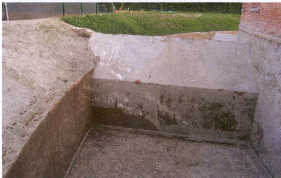
Ryc. 58c Fosa wieży artyleryjskiej po odkopaniu. Widoczna przeciwskarpa z usuniętym gzymsem, wschodnią kaponiera z zachowanym fragmentem komina, w głębi śróp jednego z łączników. Zdjęcie: S. Fuglewicz, czerwiec 2018 r.
