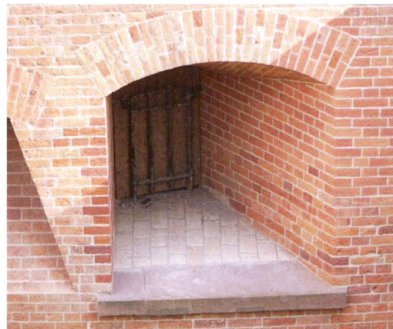
Ryc. 39m Zachodnia strzelnica artyleryjska w dolnej kondygnacji wieży z dobrze zachowaną kratą uchylną. Kamienny parapet oryginalny, po uzupełnieniu ubytków. Z lewej strony fragment strzelnicy karabinowej. Zdjęcie: Asman Pieniężny Architekci sp z o. o., styczeń 2020 r.
