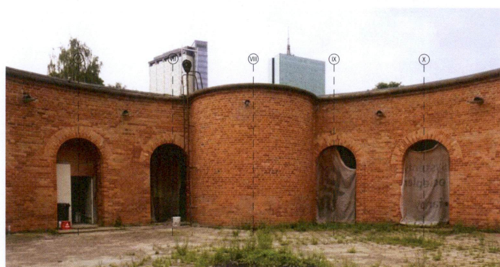
Ryc. 39r, Elewacja wewnętrzna wieży artyleryjskiej po pracach konserwatorskich wykonanych przed 2020 r. Część południowo-zachodnia z półkolistym ryzalitem dawnej klatki schodowej. Zdjęcie: Asman Pieniężny Architekci sp z o. o., lipiec 2021 r.
