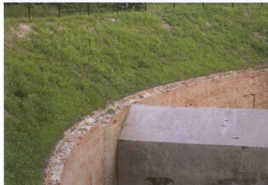
Ryc. 58d Fosa wieży artyleryjskiej - wtórny łącznik i mur przeciwskarpy z gniazdem po usuniętym gzymsie kamiennym, po prawej fragment płyciny imitującej wejście. Zdjęcie: S. Fuglewicz, czerwiec 2018 r.
