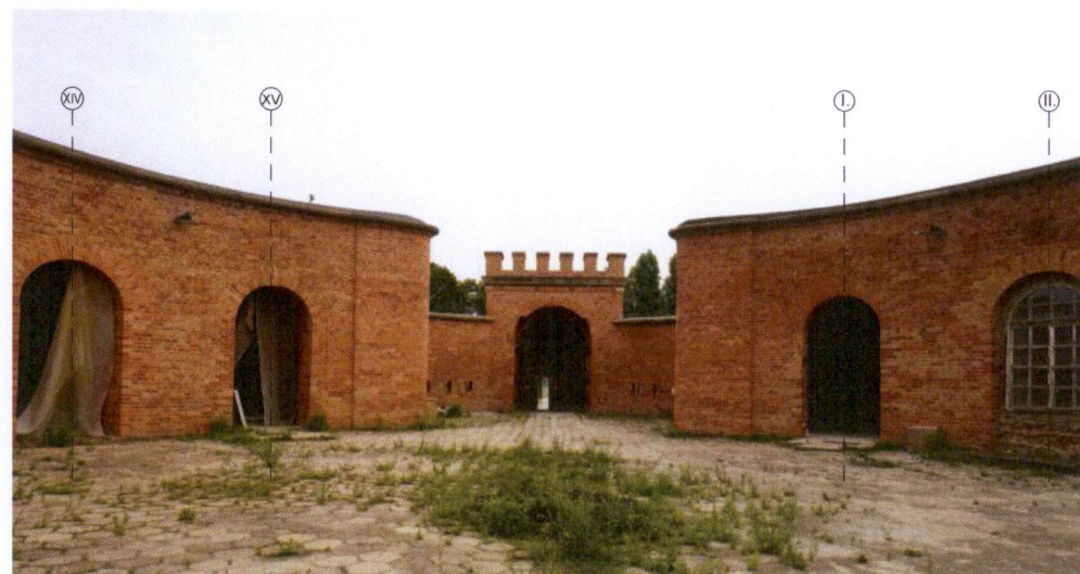
Ryc. 39n, 39o Elewacja wewnętrzna wieży artyleryjskiej po pracach konserwatorskich wykonanych przed 2020 rokiem - część zachodnia i północno-wschodnia. Osie oznaczone według rysunku rzutu 39a. Dziedziniec pokryty trylinką ułożoną na bruku i zasłaniającą część cokołu. Pośrodku nadmurowana cembrowina odkopanej studni, zabezpieczona kratą. Zdjęcie: Asman Pieniężny Architekci sp z o. o., lipiec 2021 r.
