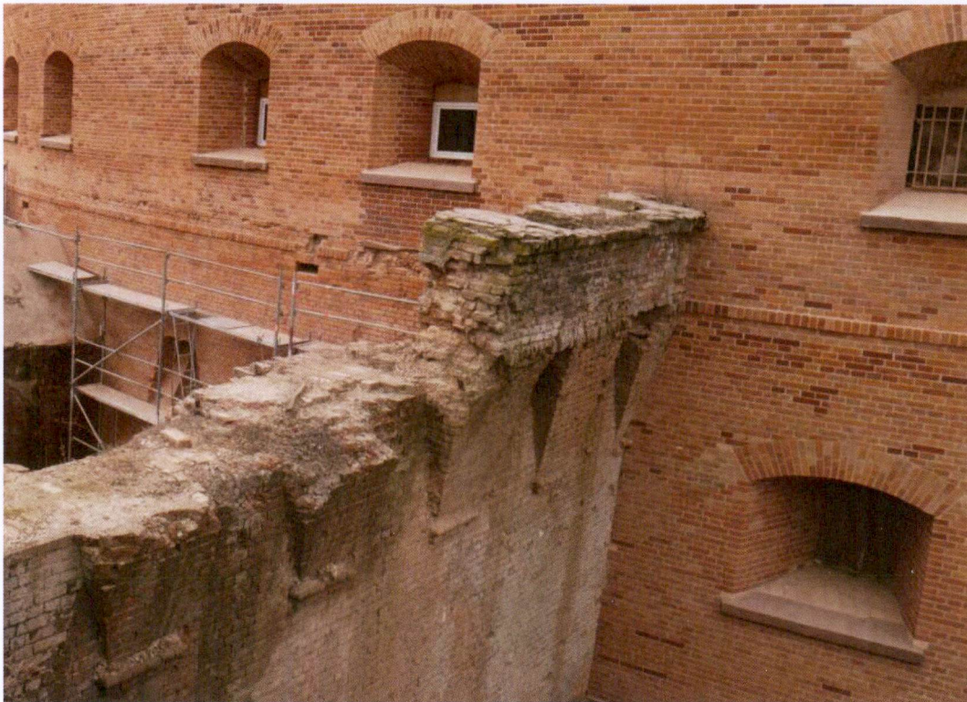
Ryc. 58e. Odcinek muru szyjowego lunety przy wschodniej elewacji wieży artyleryjskiej z zachowanymi kroksztynami i fragmentem przedpiersia przykrytego płytkami ceramicznymi. W koronie muru widoczne pozostałości żelaznych kotew wzmacniających przedpiersie. Na prawo od muru w dolnej kondygnacji strzelnica artyleryjska. Dolna część elewacji wieży w końcowym etapie prac konserwatorskich. Zdjęcie: Asman Pieniężny Architekci sp z o. o., Marzec 2021 r.
