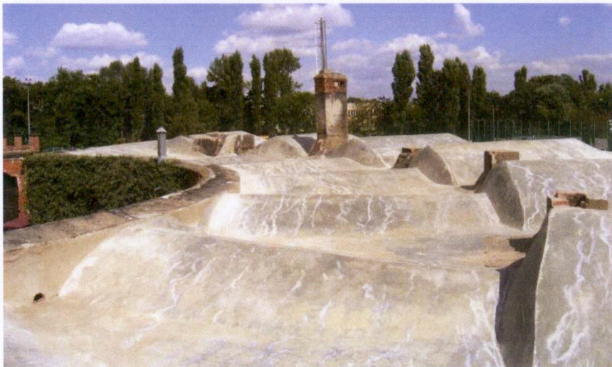
Ryc. 39w Strop wieży artyleryjskiej po zdjęciu nasypu i rozebraniu większości kominów. Zdjęcie: S. Fuglewicz, sierpień 2014 r.
