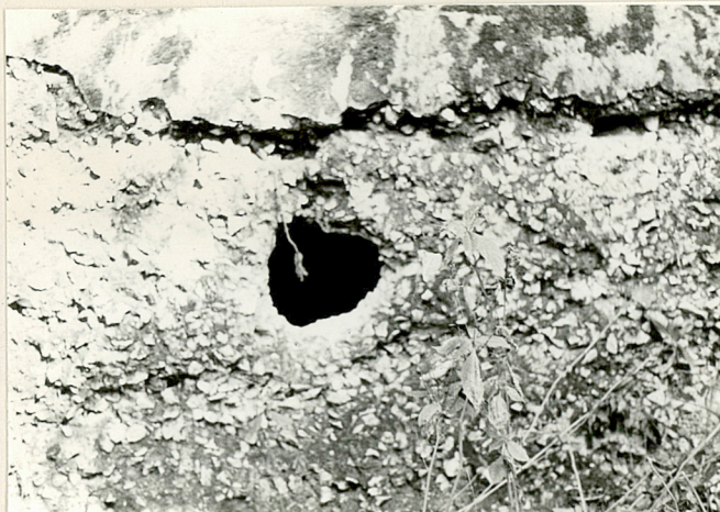
Fot.4/ Powierzchnia uszkodzonej łupiny prze lotni schronu wsch.
