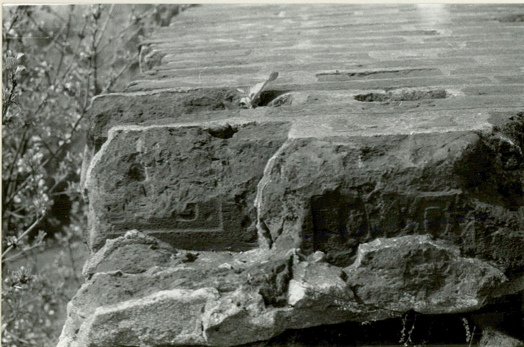
6. Układ cegieł w koronie muru oporowego przejścia.
