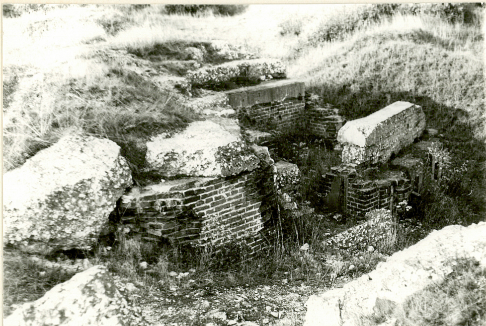
Kaponiera zapola w formie półbastionowego załamania koszar. Na 1-szym planie ślad przelotni do wału piechoty.
