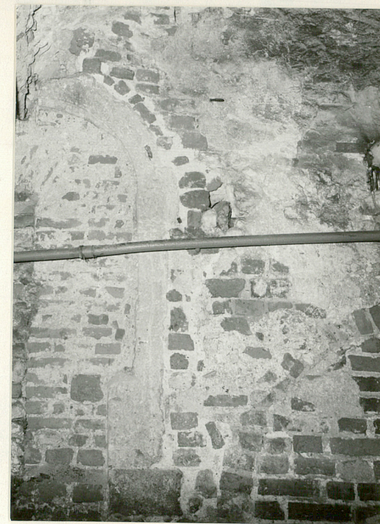
ściana rozdzielająca komory traktu frontowego skrzydła pd; widoczny zamurowany por- tal przejścia między komorami
