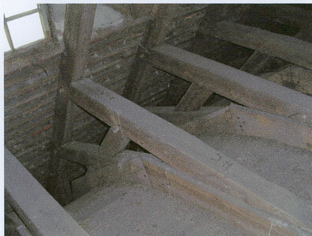
2. Konstrukcja beczkowego sklepienia pozornego
