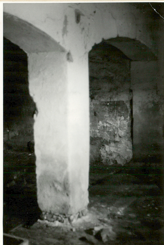
Fot. 9 - filar wspierający sklepienie kolebkowe
