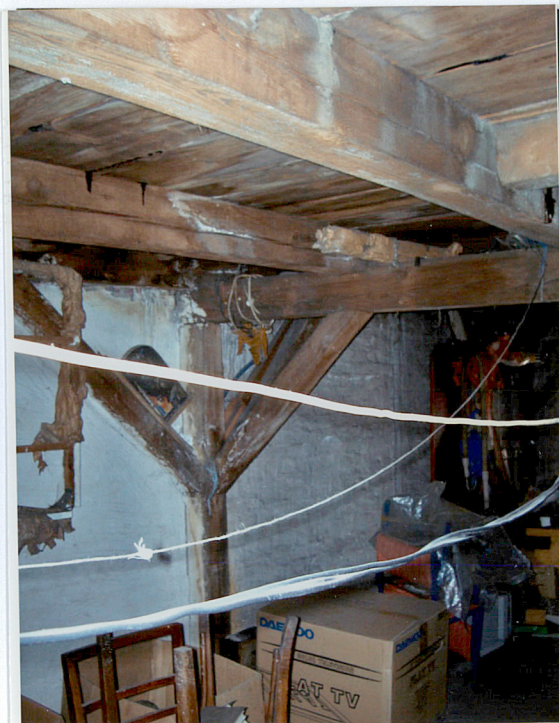
14. Poddasze – fragment więźby dachowej.
