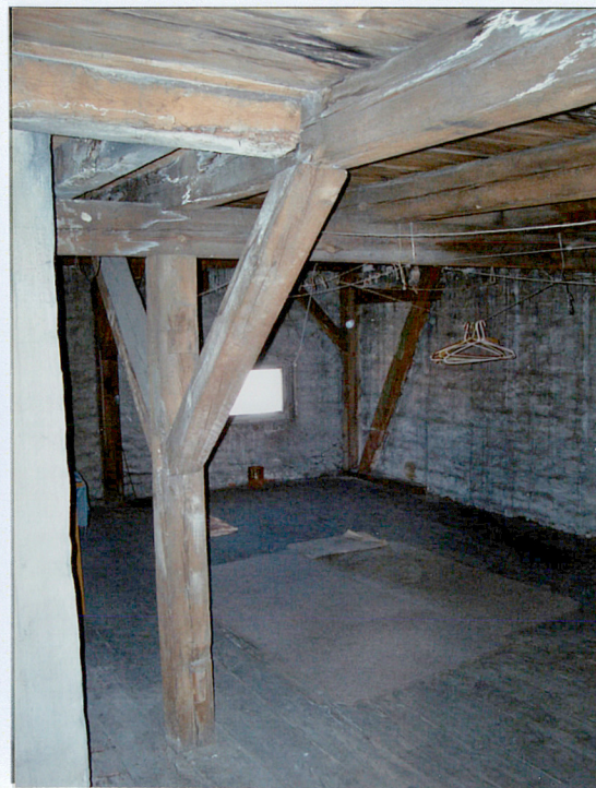
15. Poddasze – fragment więźby dachowej.
