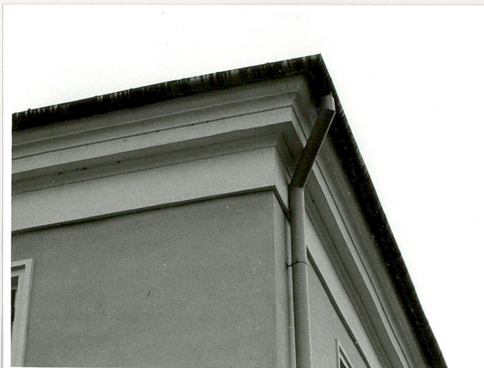
profil gzymsu koronującego
