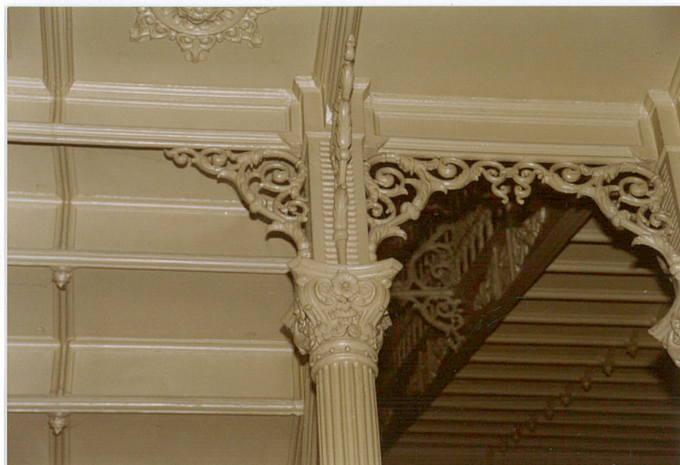
Fragment wspornika podestu schodów głównej klatki schodowej.
