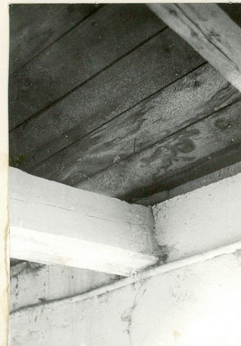
Belka poprzeczna wmontowana w płatew
