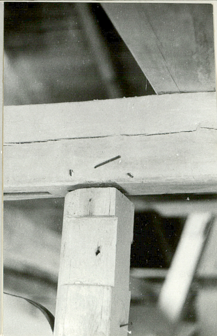
Słup podpierający belkę poziomą I kondygnacji
