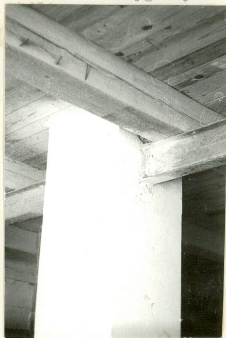
Metalowy dwuteownik podtrzy- mujący belki poziome.
