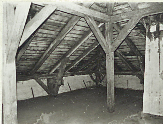
33. Więźba dachowa - poddasze.
