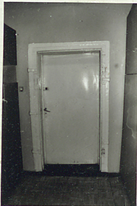
24. Wzmocniona futryna poprzedniego pom. kasy.
