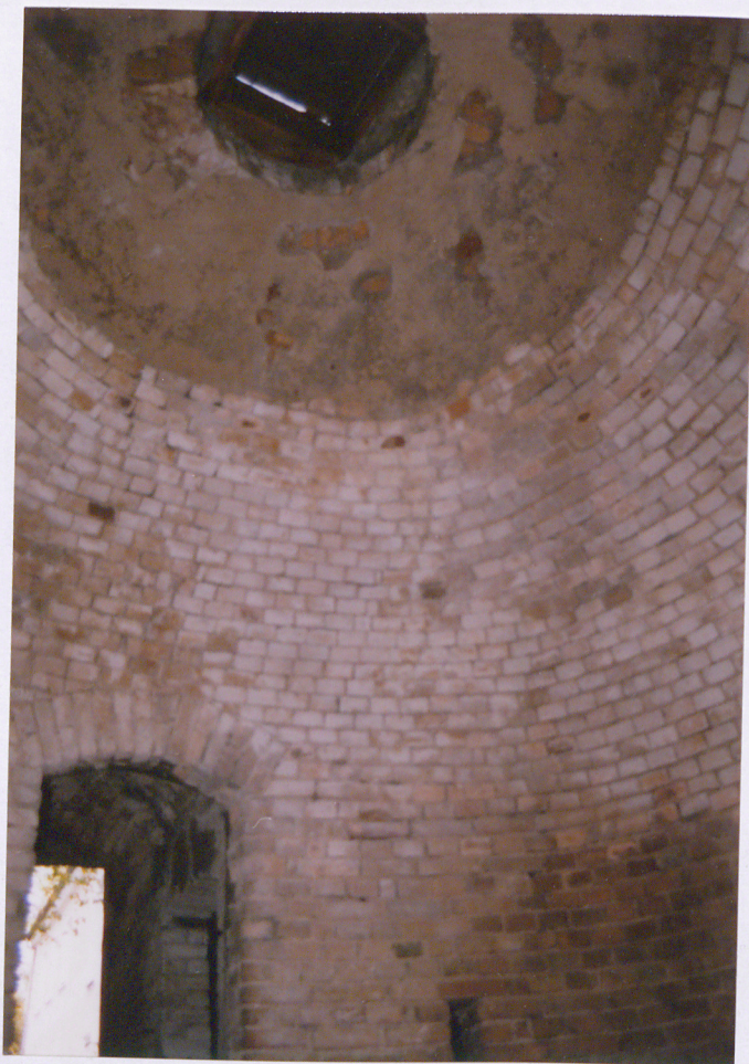
13. Wnętrze właściwej piwnicy, widoczne sklepienie i otwór wejściowy na korytarz, a w głębi otwór zewnętrzny
