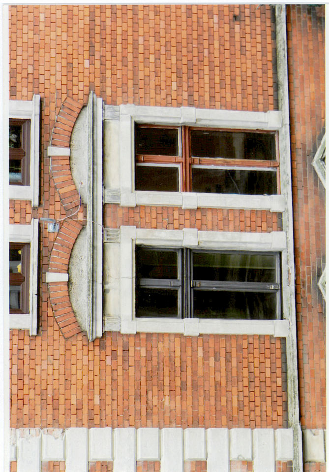
Fot. 5 – Elewacja zach.. Okna na 2 piętrze z zachowaną zabytkową stolarką.
