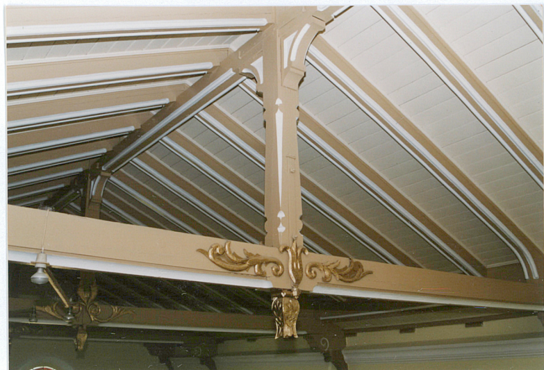
28.fragm. otwrtego wiązania dachowego
