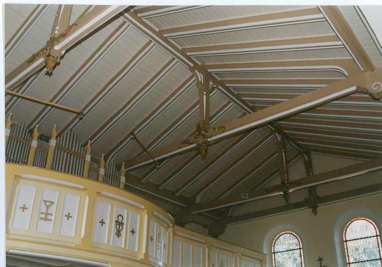
27.otwarte wiązanie dachowe nad partią zach.
