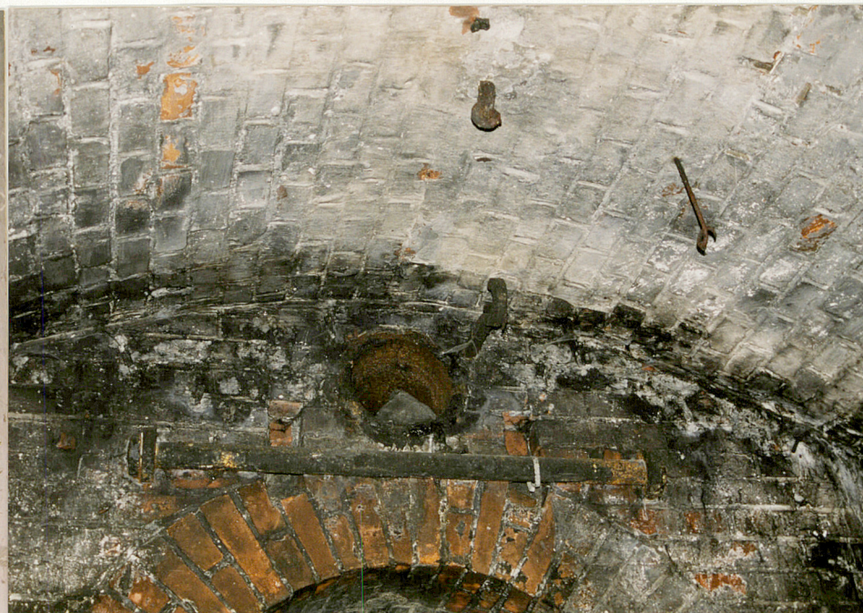
16. Fragment ściany przedniej (wejściowej) komory koszarowej (nad oknem) - zawiesie płyt pancernych i otwór wydiewny wentylacji grawitacyjnej
