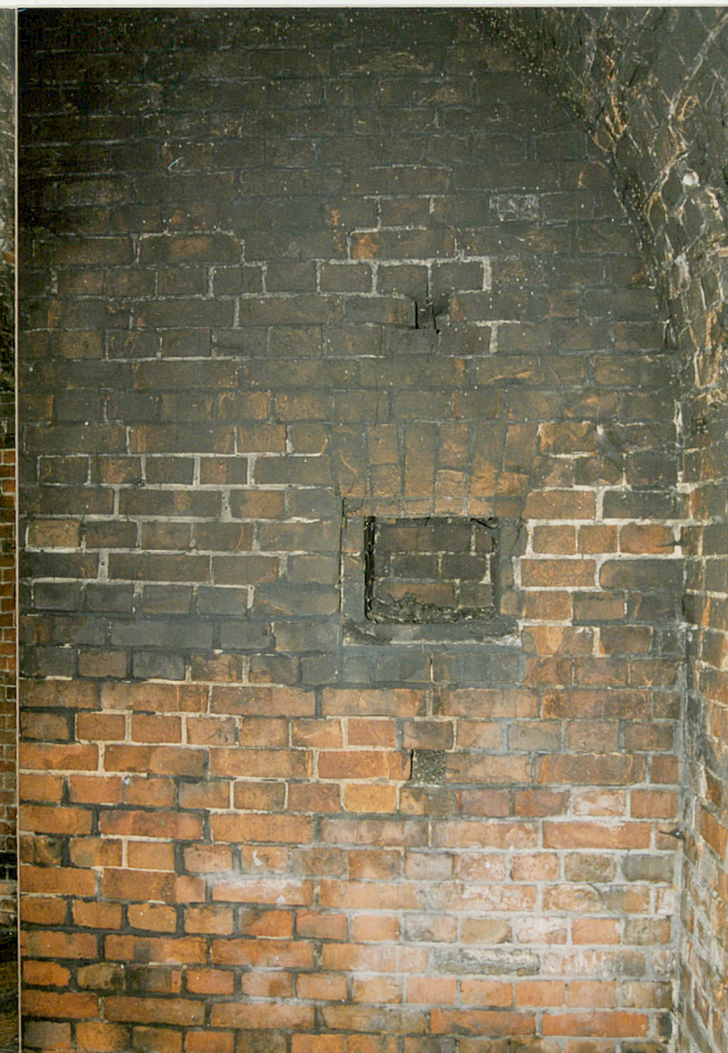
11. Komora amunicyjna, ściana przednia (ele- wacyjna), wnęka oświe- tleniowa.
