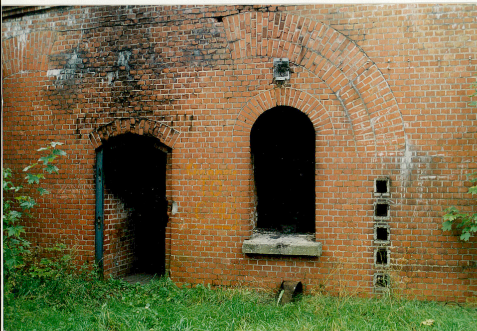
9. Fragment elewacji lewego skrzydła - wejście do komór amunicyjnych, otwór okienny i wyloty kanałów wentylacji.
