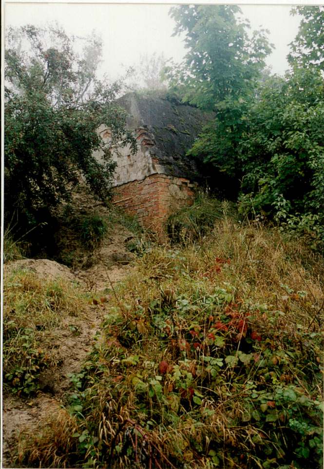
3. Kraniec lewego muru oporowego w linii elewacji schronu (widoczne betonowe bloki lica nadstawy, nasyp obsunięty).
