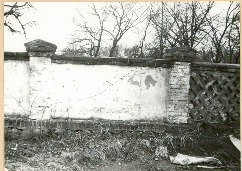
Różne typy muru z cegły ceramicznej otaczającego podwórze gospodarcze:
