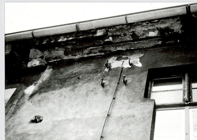
17.stan gzymsu podokapowego, od pld.
