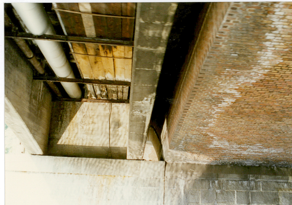
8. Żelbetowe belki z przebudowy mostu w 1934 r., neg. 500/81/4
