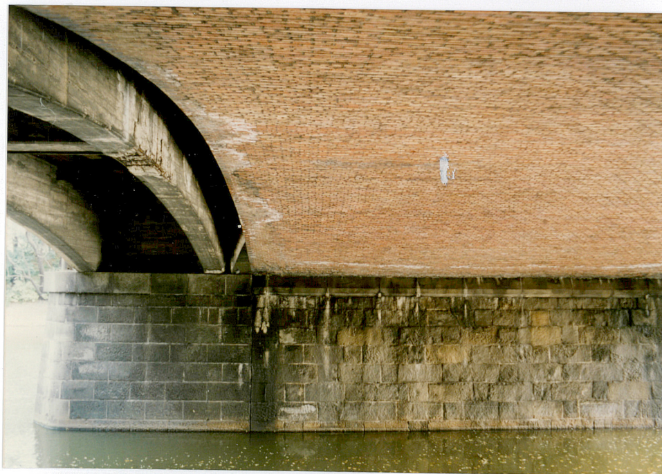
7. Sklepienie z cegły mostu z 1888 r., neg. 500/501/1
