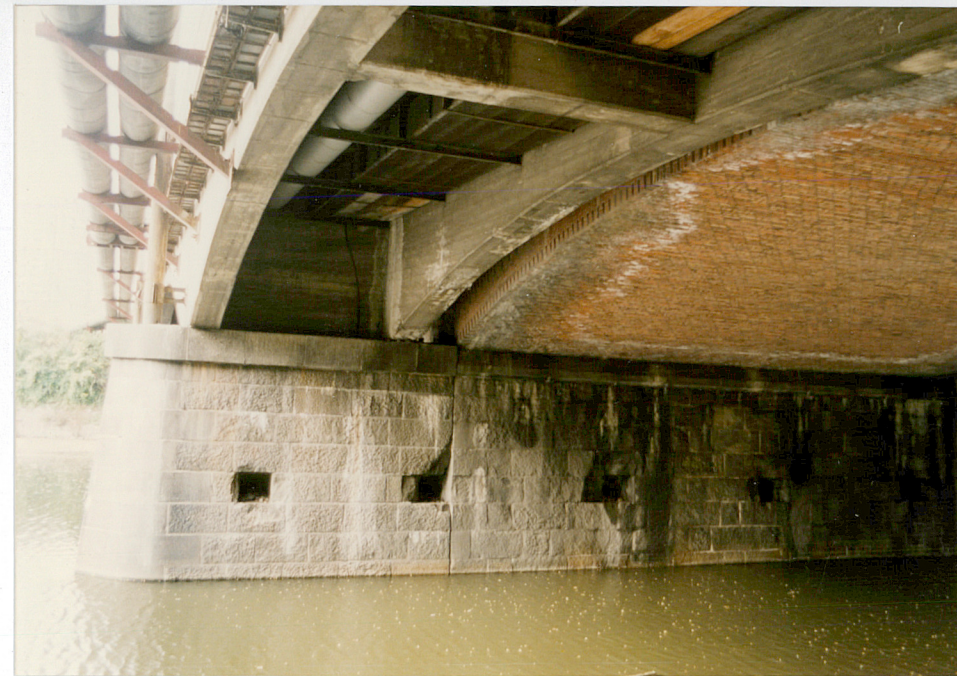
6. Posadowienie przęseł na filarze, neg. 500/499/5
