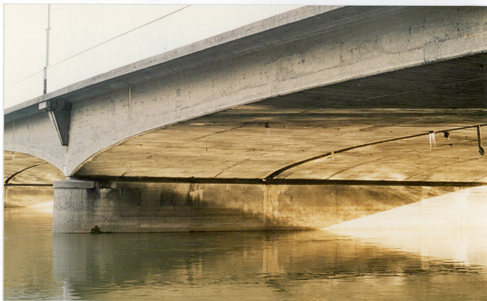
6. Filar i widok przęsła od dołu. Widoczna szczelina dzieląca most na dwie części, neg. 400173/2
