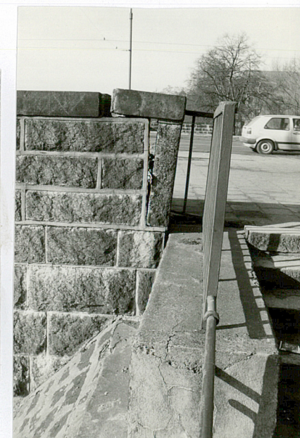
10. Uszkodzona bariera nad przyczółkiem, neg. 400/324/2
