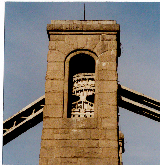
11. Łożysko kolebkowe na wieży pylonu, neg. 400/284/2
