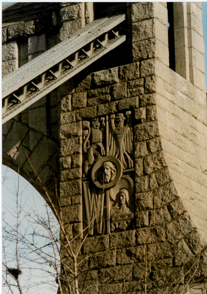
4. Pylon mostu licowany kamieniem granitowym, neg. 400284/3
