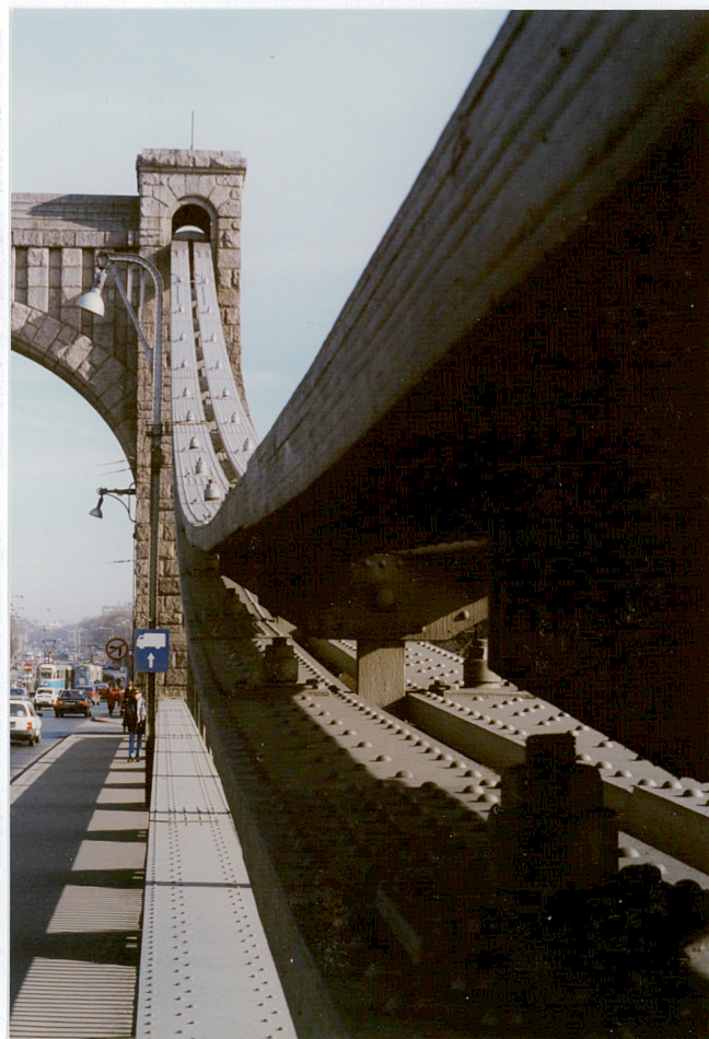
7. Wieszaki łączące pasy z pomostem, neg. 400/303/5
