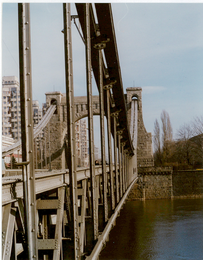
7. Wieszaki łączące pasy z pomostem, neg. 400/303/5
