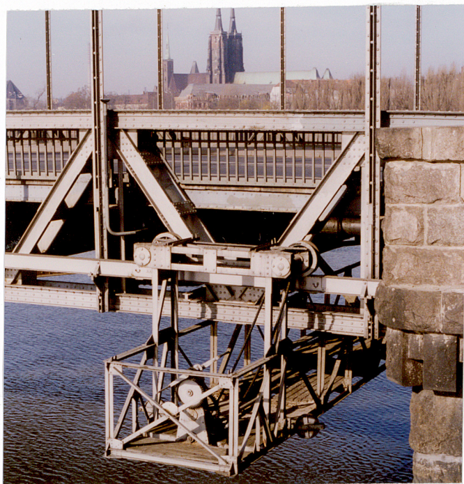
10. Wózek rewizyjny podwieszony pod konstrukcją pomostu, neg. 400/304/2
