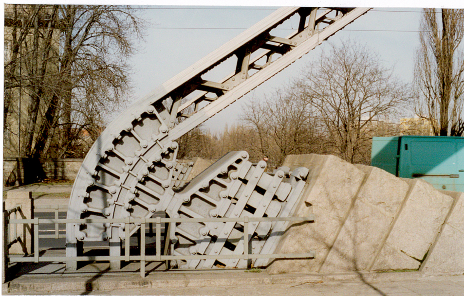
12. Łożysko kolebkowe nad zakotwieniem pasów, neg. 400/303/2
