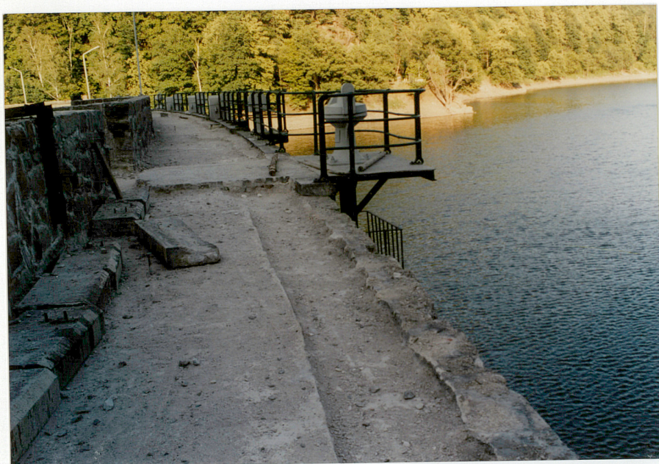
4. Korona zapory w trakcie remontu stalowej bariery, neg. 500/25/5
