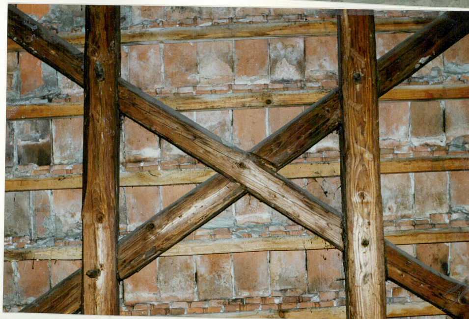
Wzmocnienie krokwi
