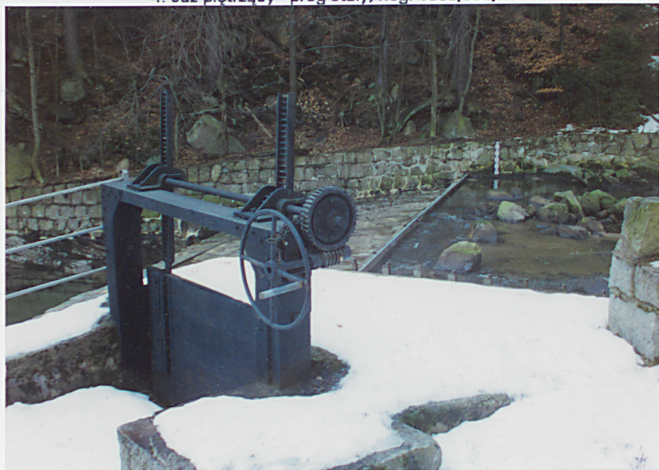
6. Zasuwa płaska na wlocie do kanału energetycznego, neg. 1000/391/3
