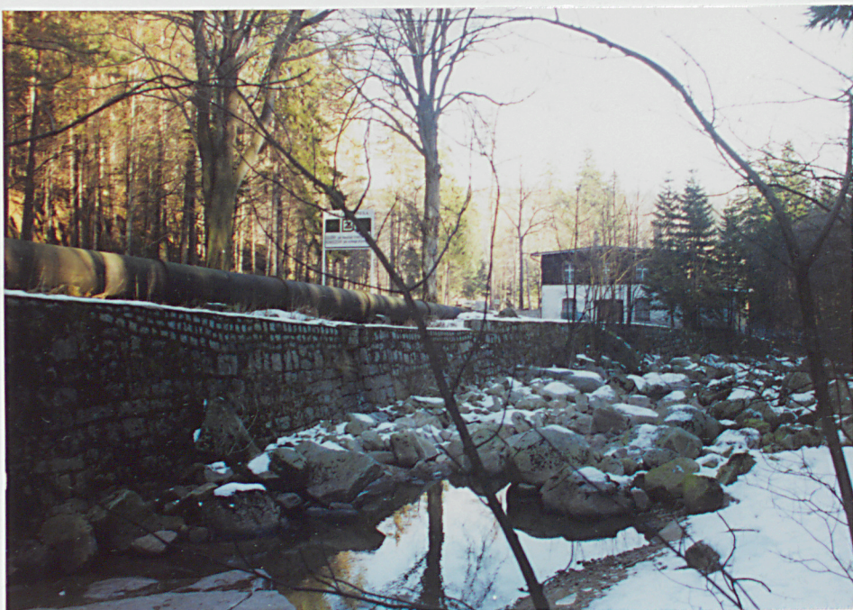
4. Koryto rzeki Kamiennej i rurociąg energetyczny prowadzony na umocnionym lewym brzegu. neg. 1000/392/6
