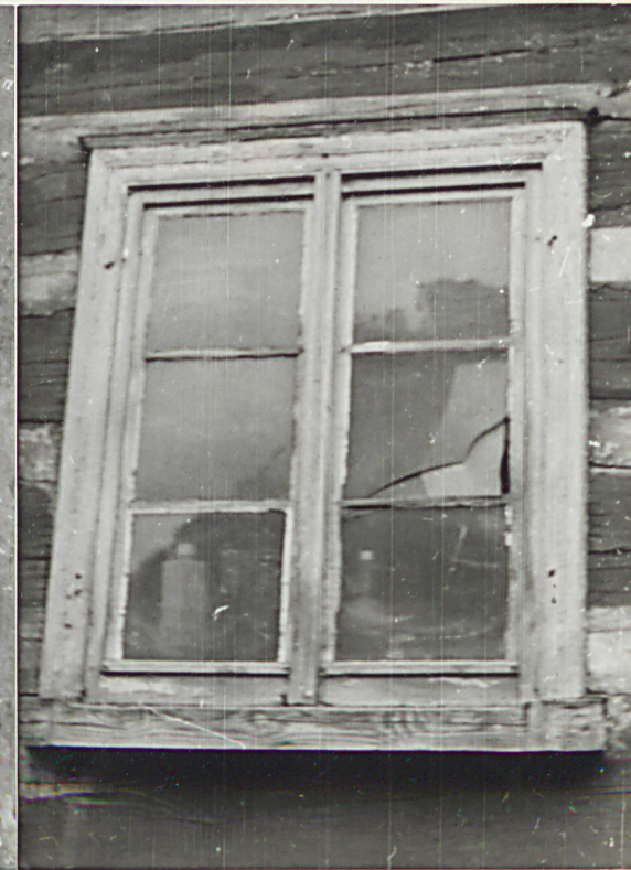
Okno w ścianie zrębowej
