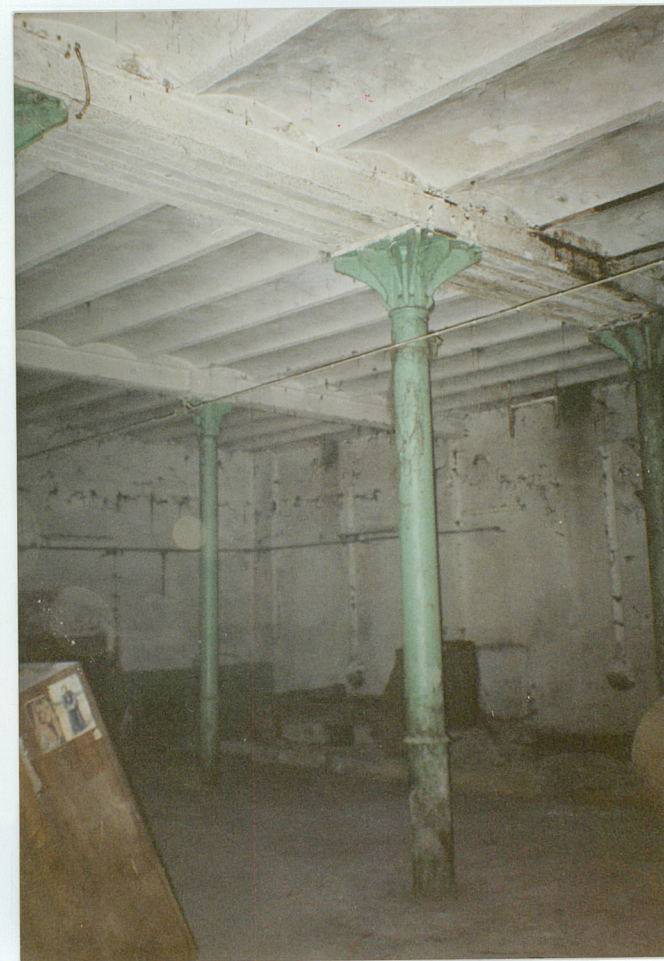
5. Wewnętrzna konstrukcja nośna w pomieszczeniu stacji uzdatniania wody, neg. 1000/156/1.
