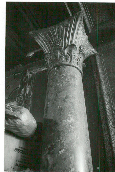
Kolumna podtrzymująca podciąg między pomieszczeniami pd. parteru.
