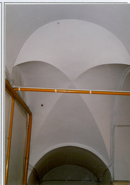
17. Sklepienie klatki schodowej w dolnym biegu (od wejścia głównego).
