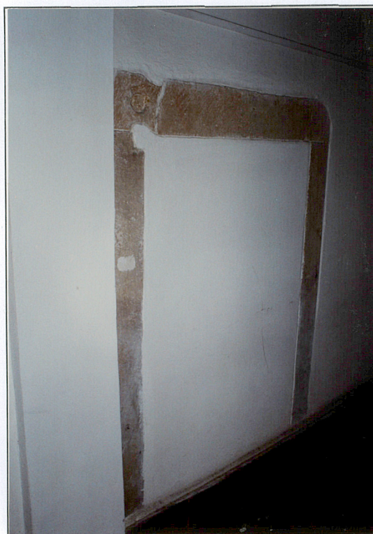
10. Zamurowane przejście w sieni (ściana zachodnia)
