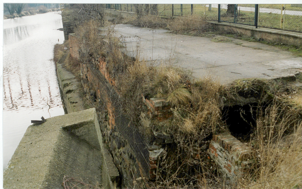
7. Zniszczony bulwar przy przejściu ze ściany pionowej w skarpe basenu dawnej stoczni, neg. 1100/917/3
