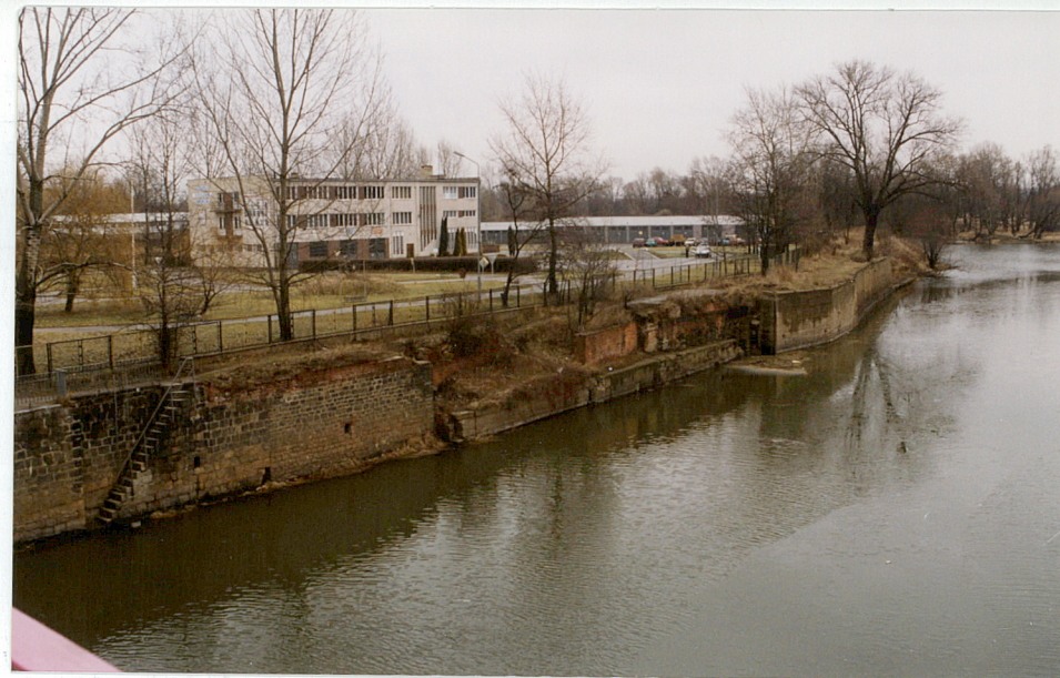
5. Kamienno-ceglany bulwar nabrzeża powyżej mostu drogowego, neg. 1100/915/6
