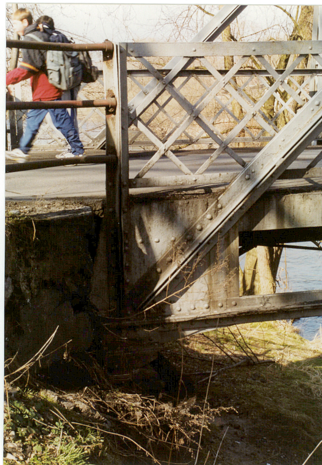
5. Posadowienie przęsła na lewym przyczółku, neg. 1000/654/1
