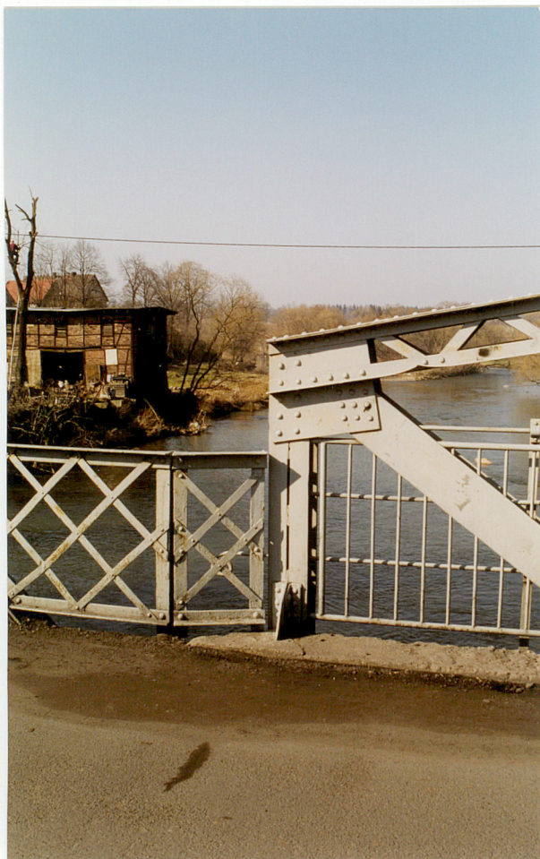
4. Słupek skrajny przęsła i stalowa bariera w strefie nad filarem, neg. 1000/653/4
