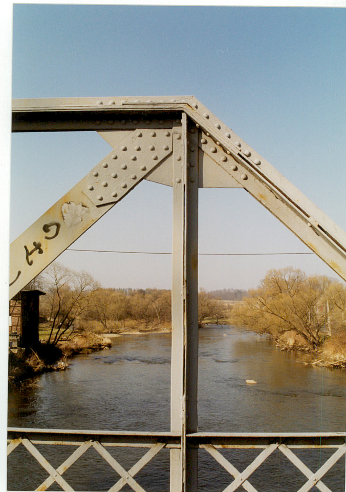
6. Skrajny węzeł pasa górnego dźwigara kratowego przęsła lewego, neg. 1000/653/5
