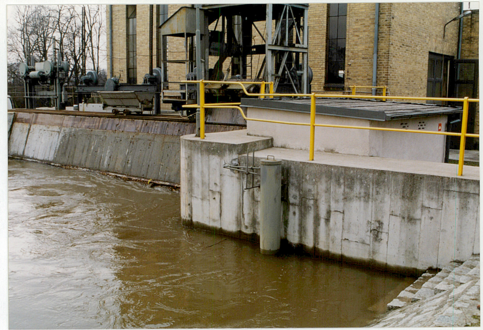
2. Wlot kanału roboczego z zasuwami i urządzeniem do czyszczenia krat, neg. 1000/543/6
