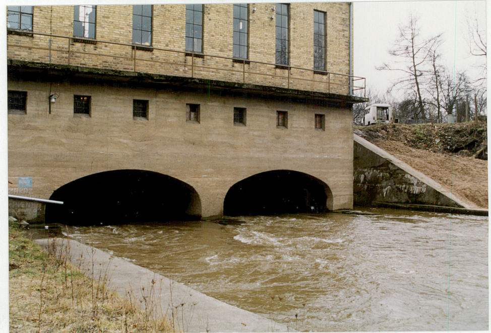
4. Wylot kanałów roboczych - dolne stanowisko, neg. 1000/534/1
