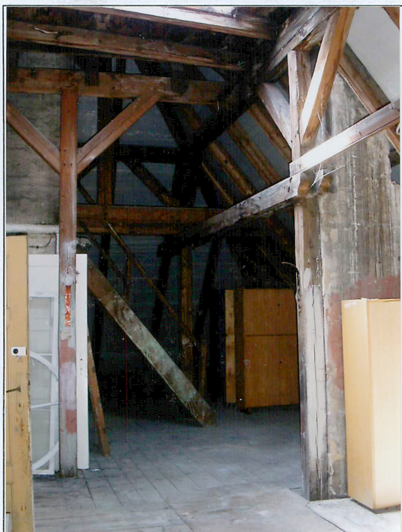
7. Fragment nieużytkowanej części poddasza z widokiem na konstrukcję więźby dachowej i drabiniaste schody prowadzące na strych.
