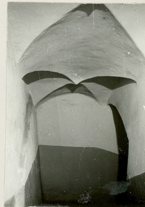
fot.12 sklepienie nad biegiem schodów
