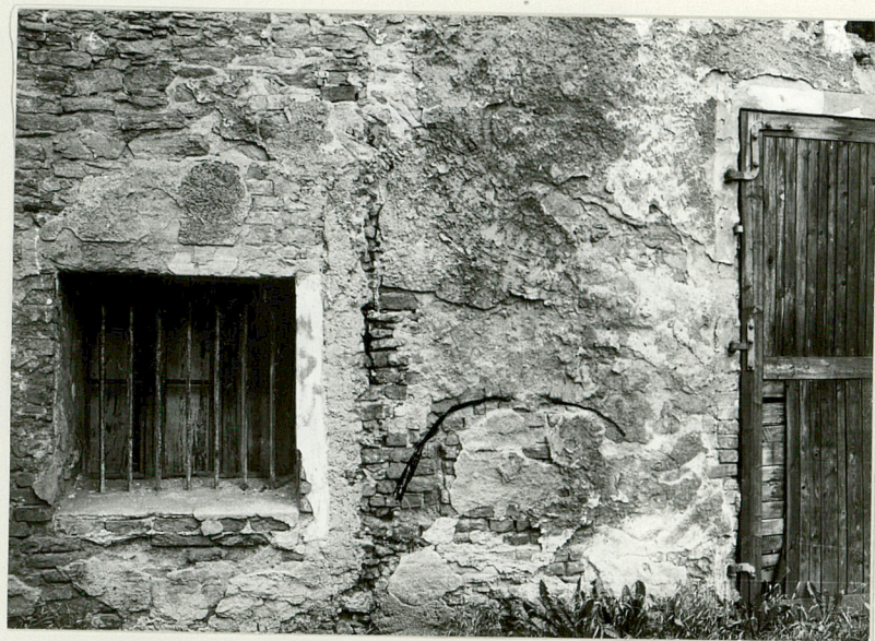
8. Elewacja pd. - ślady prze- murowań /nadproża pierwot- nych otworów ?/.
