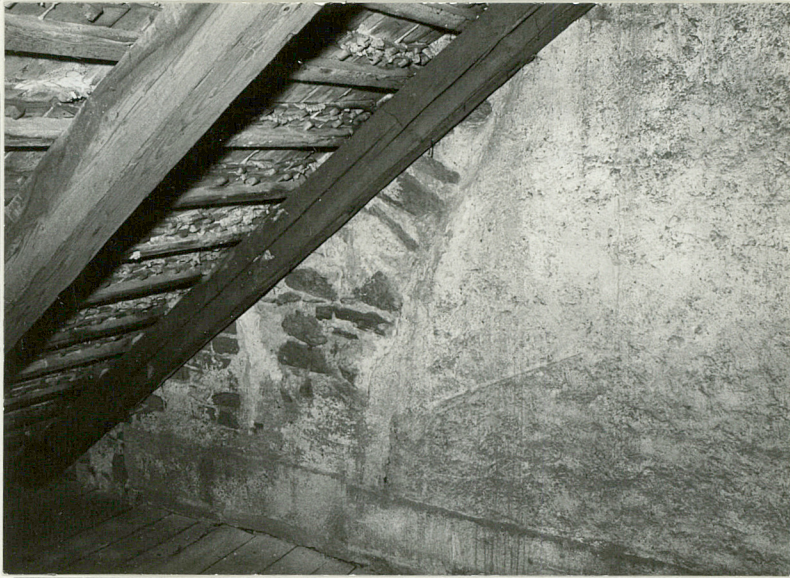
21. Poddasze - ślady zmian nachylenia dachu klasztoru.
