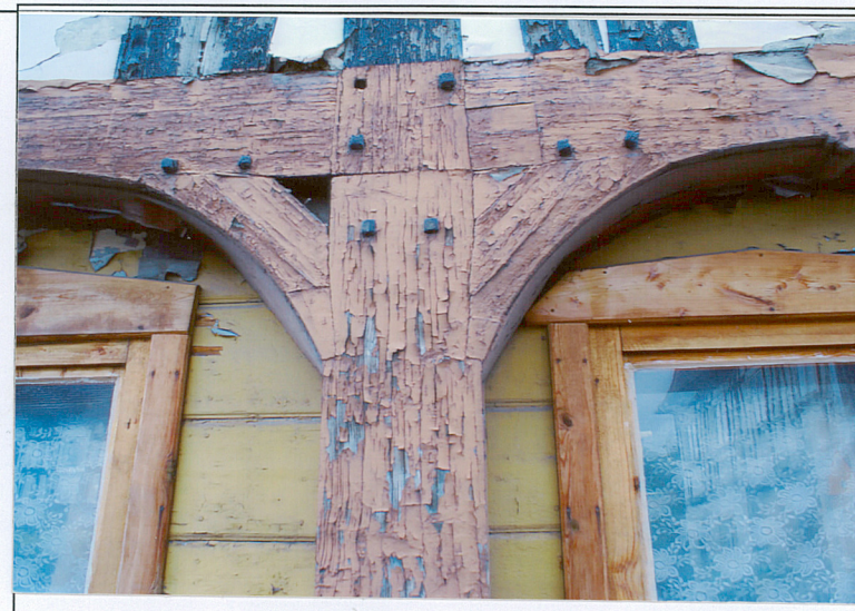
13. Konstrukcja przysłupowa-fragment.
