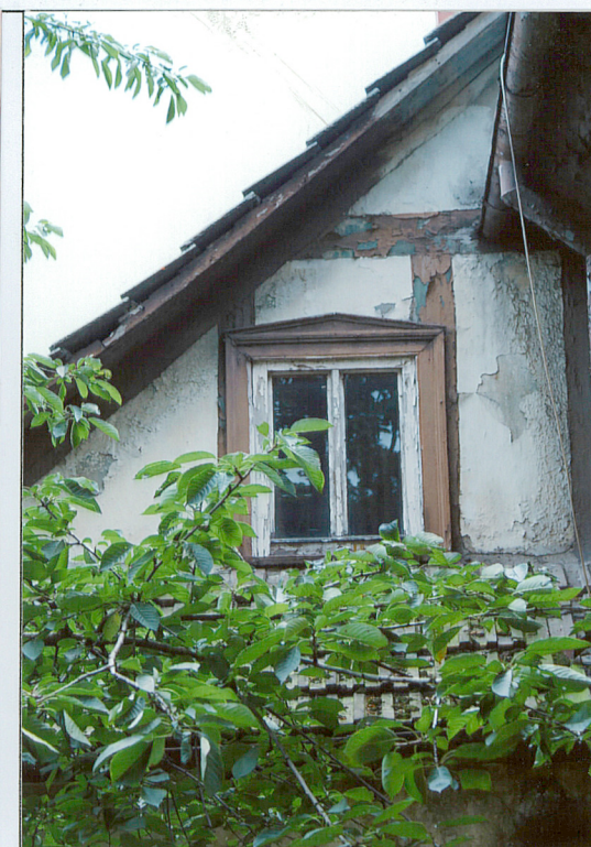
7. Okno piętra części gospodarczej z widoczną konstrukcją ryglową.
