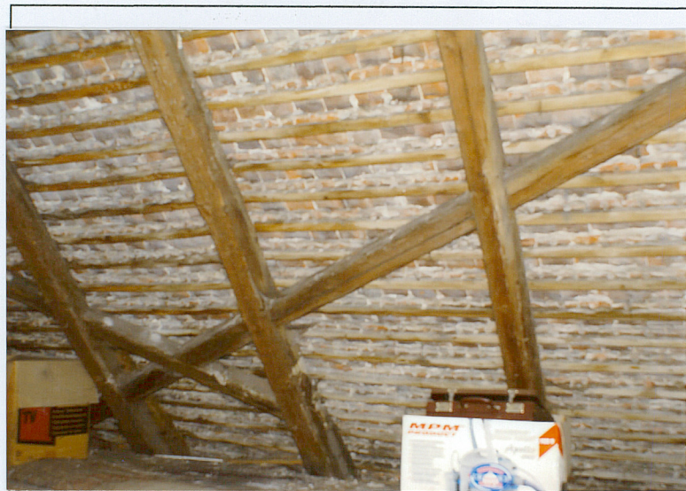
19. Wieżba dachowa - fragment, wiatrownica w kształcie krzyża św. Andrzeja
