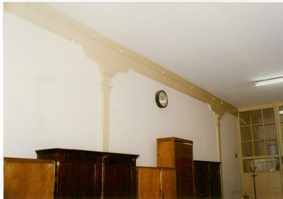
5. Wnętrze - widoczny fragment ścianki działowej i układu konstrukcyjnego dawnej hali produkcyjnej (stupy, podciąg), neg. 500/788/6.
